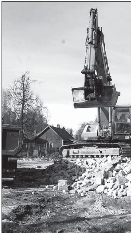
Lammutustööd hakkasid peale vanadest garaazidest.
