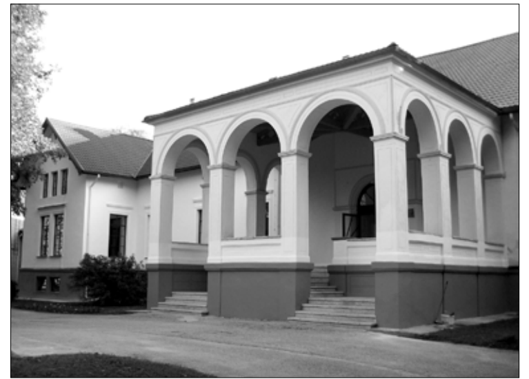
Работа школы в имении Прууна позволила сохранить внешний вид старинного здания.
