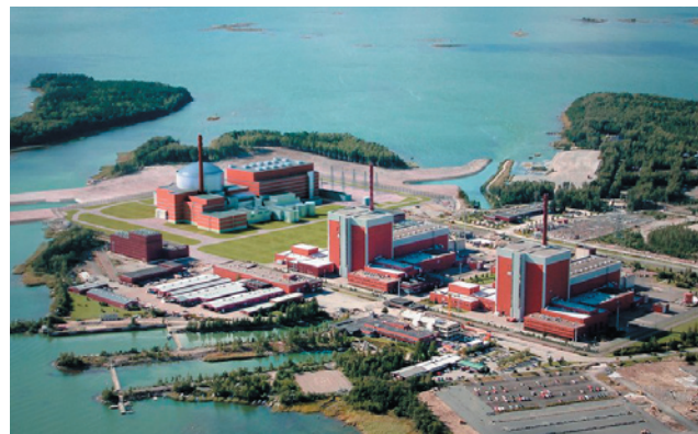
Olkiluoto tuumajaam Soomes
