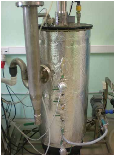
Foto 2. Anaeroobne kääriti. Photo 2. Anaerobic digester.
