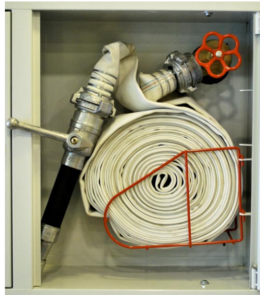
Lamevoolikuga voolikusüsteem, mis üldiselt haiglasse ja hooldekodudesse ei sobi
