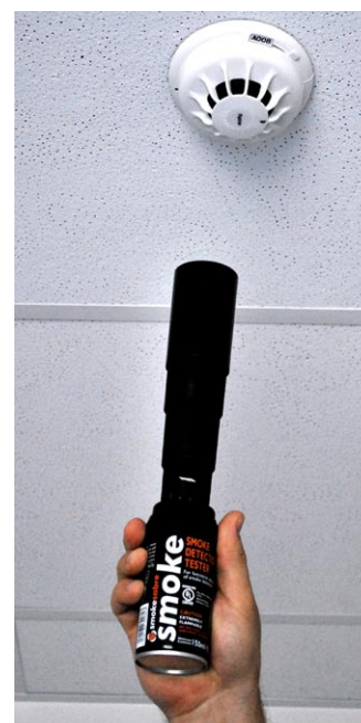
ATS-i katsetamine testaerosooli abil
