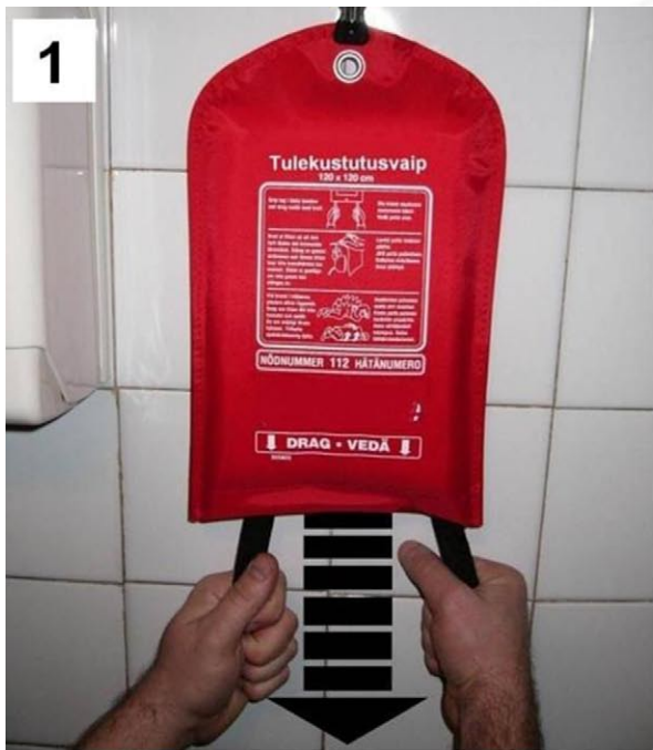
Tulekustutusvaiba kasutamine: 1 – tõmba vaip kotist välja ja lase lahti rulluda, 2 – iseenast kustutusvaibaga leekide ja pritsmete eest kaitstes aseta vaip tihedalt tulekoldele
