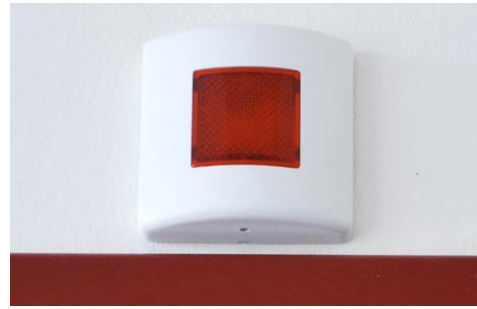
Indikaatorlamp ukse kohal osutab hästi nähtavalt häirekohale
