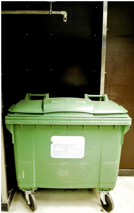
Kohtsprinkler jäätmekogumisruumis
