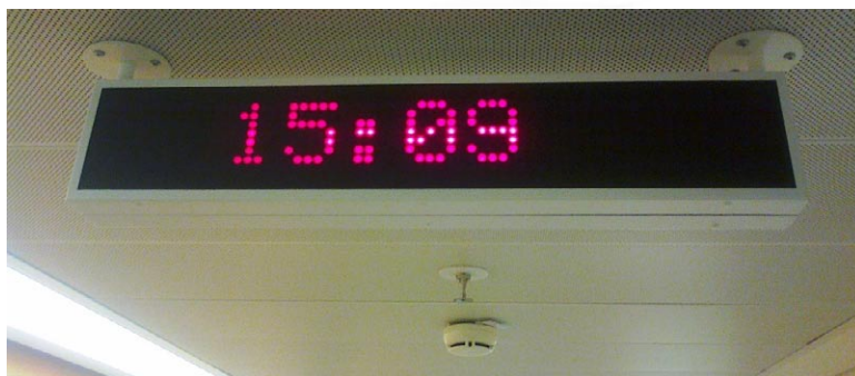
Õekutsesüsteemi LED-tabloo Kölni Ülikooli kliinikumi peahoones, mis tulekahjuteate korral kuvab kirja "FFF"
