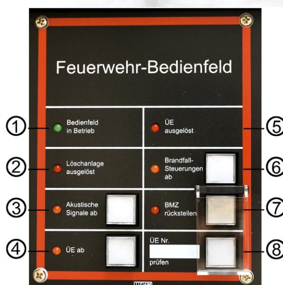
Saksa ATS abipult: 1 - pult on töös, 2 - kustutusseade on käivitunud, 3- akustilise alarmi vaigistamine, 4- signaaliedastuse katkestamine, 5 - signaal on edastatud häirekeskusesse, 6 - blokeeringute katkestamine, 7 - ATS taastamine, 8 - signaaliedastuse katsetamine
