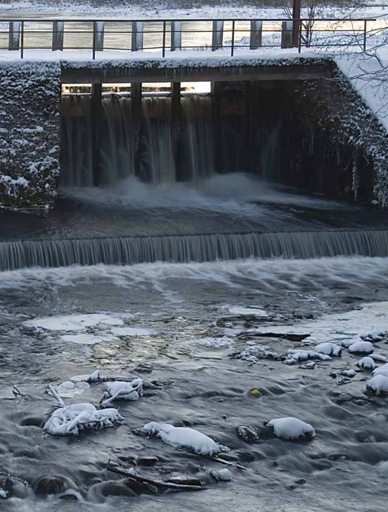
Valgejõgi Kotka pais
