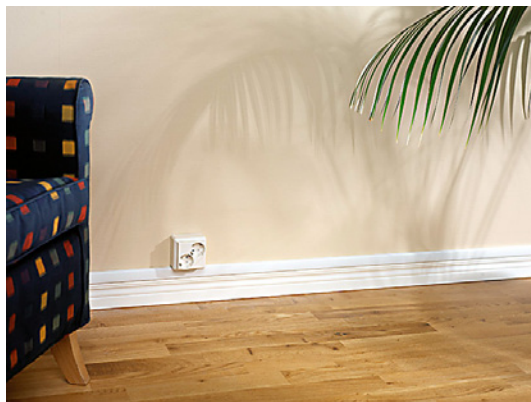
Joonis 9.17. Karbikusse paigaldamine kapitaalremondi objektil (Schneider).
