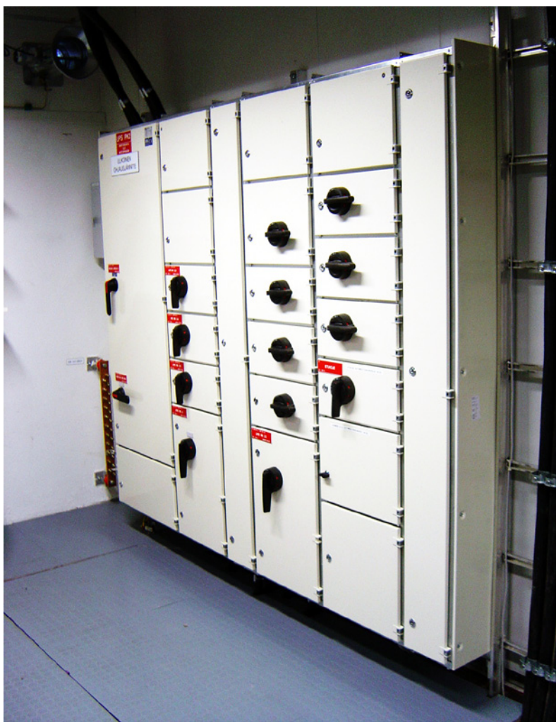
Joonis 12.4. Kilbis paiknevad käidutoimingute käigus kasutatavad seadmed tuleb paigaldada sellisele kõrgusele, et nende käit toimuks turvaliselt.
