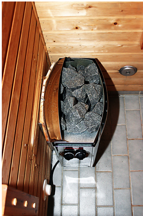
Joonis 15.17. Kerise juhtlülitite asukohta tuleb kindlasti arvestada.
