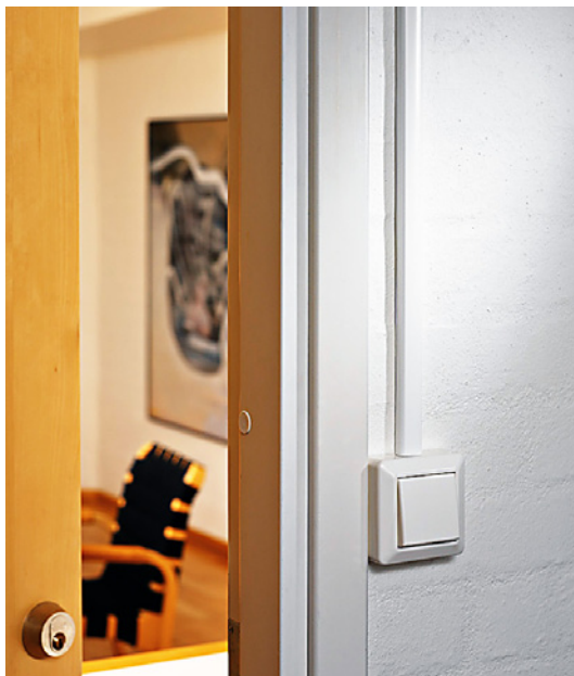
Joonis 9.2. Karbikuga paigaldamisel jääb pinnapealne paigaldus sageli esteetiliselt ilusam (Schneider).
