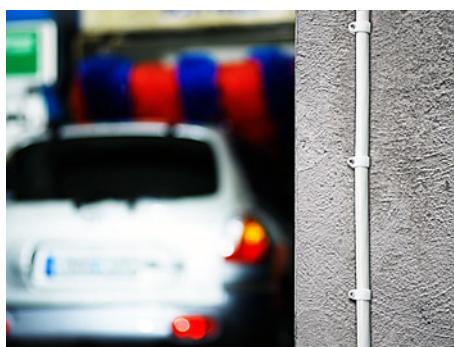
Joonis 9.7. Pinnapealne paigaldus kergkruusast aluspinnale (Schneider).
