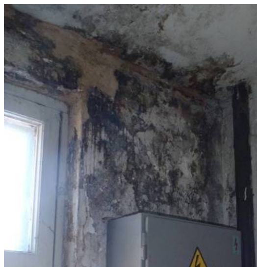
Joonis 9.7 Lokaalne hallituse kasv küllastustemperatuurist madalama temperatuuriga tsoonis kolmanda korruse korteris (vasakul). Hallituse kasvu soodustab ebapiisav õhu liikumine välisseina ja kirjutuslaua vahelise tsoonis. Kivitrepikeja laenurgas olevat hallituskahjustust on aasta tagasi tõrjutud ja aktiivset kasvu hiljem ei olnud (paremal).
