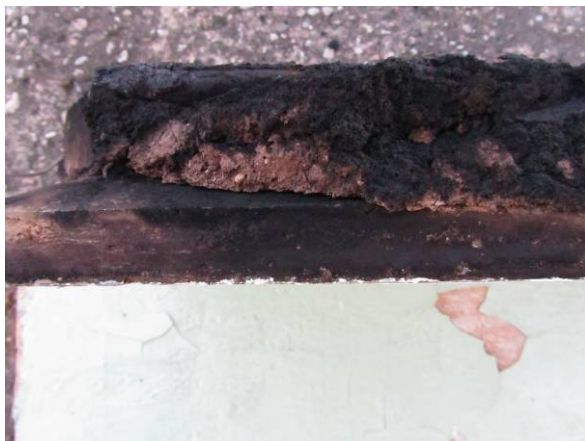
Joonis 10.1 Ahjupoti (vasakul) ja ahjukivi (paremal) otsapind reedab, et kividevaheline vuuk ei ole terviklik: ajapikku on müürimört ära lagununud.
