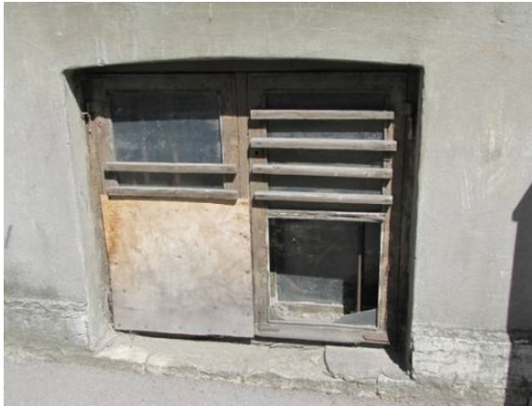
Joonis 2.66 Maapinna tasandil olevad aknad on tihti lõhutud või lagunenud suure veekoormuse tõttu.
