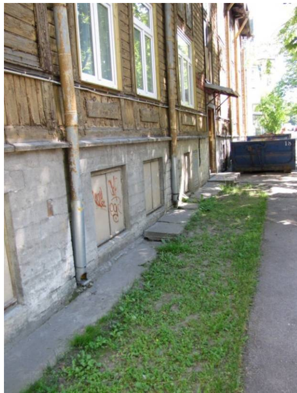
Joonis 2.45 Soklit on parandatud. Puitvooder tuleb samuti parandada, et kaitsta palke (vasakul). Sillutisriba peab olema kaldega hoonest eemale (paremal).
