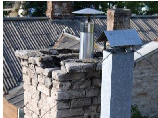
Joonis 2.72 Lagunenud korsten tuleb viivitamatult renoveerida.
