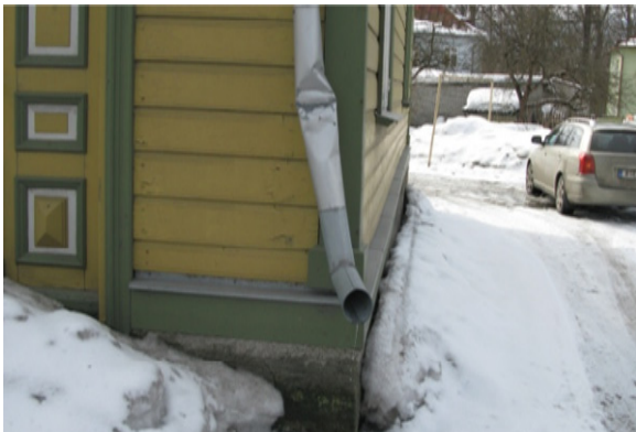
Joonis 2.18 Tänaväärsed sademeveetorud võivad sattuda vandalismi ohvriks.
