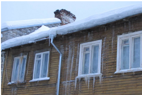
Joonis 2.30 Välisseina niiskuskahjustuste allikad: vee valgumine seinale vihmavee torust, antennikaabli kaudu, lumesulamisvee valgumine seinale.
