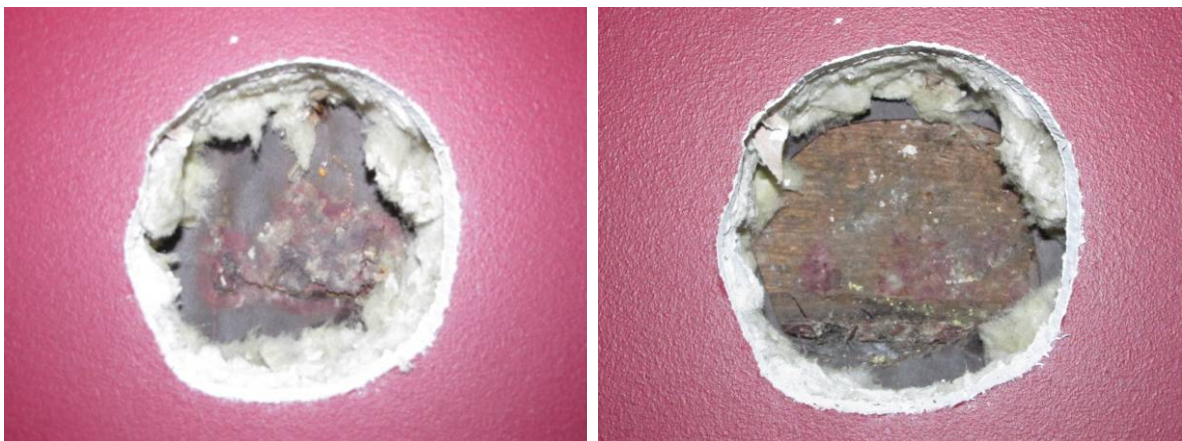
Joonis 5.25 Nähtav hallituse kasv seinas pärast seinas avamist.
