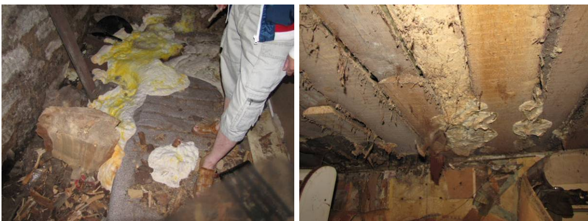
Joonis 9.5 Ulatuslik majavamm kahjustus keldri põrandal (vasakul) ja keldri vahelaes (paremal).
