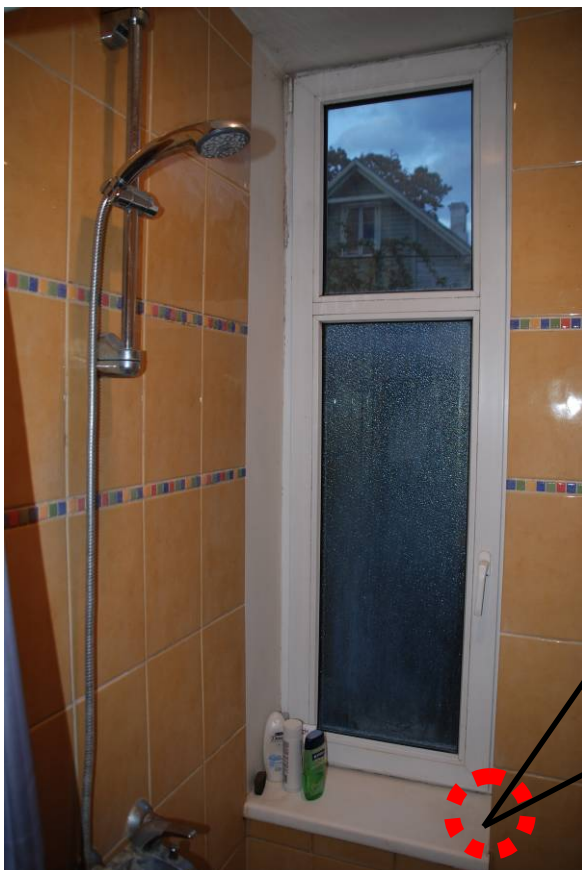
Joonis 2.68 Seinte nihete tõttu ei ole dušikabiini piirded enam veetihedad ja vesi satub tarinditesse (ülal). Dušinurk paikneb vahetult akna ääres. Akna ja välisseina liitekohas on palju potentsiaalseid veelekkekohti. Tagajärjeks on vee sattumine tarinditesse (all).
