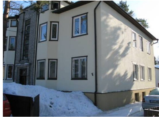
Joonis 2.25 Puitlaudisega fassaad (vasakul) ja krohvitud fassaad (paremal).
