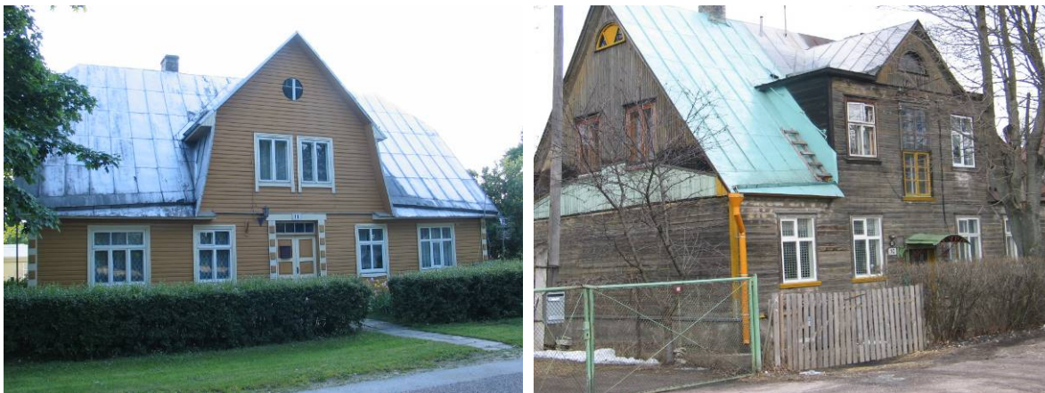
Joonis 1.23 Sellised poolteisekorruselised elamud olid väikelinnades üheks kõige levinumaks elamutüübiks 1920.–1930. aastatel (vasakul tüüpiline nn. Rakvere-tüüpi elamu Rakveres). Lisaks kivitrepikojaga korterelamutele ehitati ka Tallinna puistasumites 1920.–1930. aastatel väiksemaid elamuid, kus lisaks omaniku elamispinna oli 1–3 väiksemat välja üüritavat korterit (paremal).
