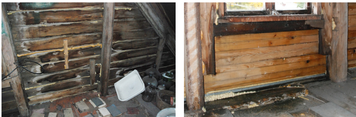
Joonis 2.35 Välisvoodri juures tuleb arvestada, et see ei ole veetihe: kaldvihma korral laseb vett läbi.
