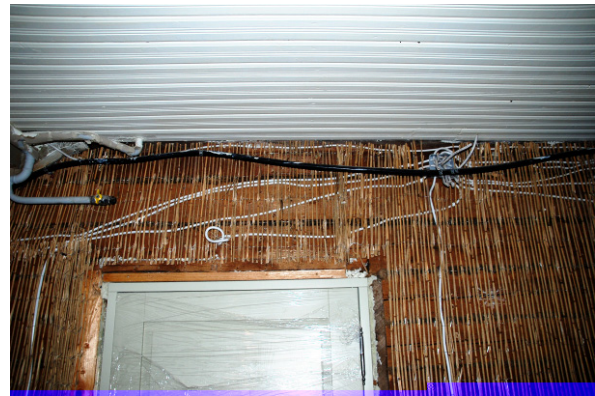
Joonis 10.6 Uus krohvialune kaabeldus on paigaldatud „risti-rästi“ üle seina ja hiljem on ohtlik seinale millegi kinnitamiseks auku puurida.
