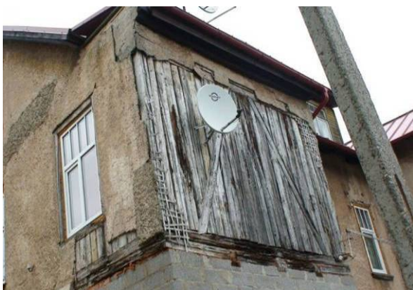
Joonis 2.37 Krohv on liigniiskuse tõttu eemaldunud ja palgid mädanikkahjustustega (vasakul). Krohvi lagunemine on alguse saanud tsementlaastplaatide (TEP-plaadid) liitekohtadest (paremal).
