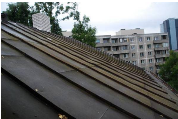
Joonis 2.7 Plekk-katuste lekkimise ja lagunemise peamised põhjused: katusekatte korrosioon, lekkes valtside ja liidete juures.
