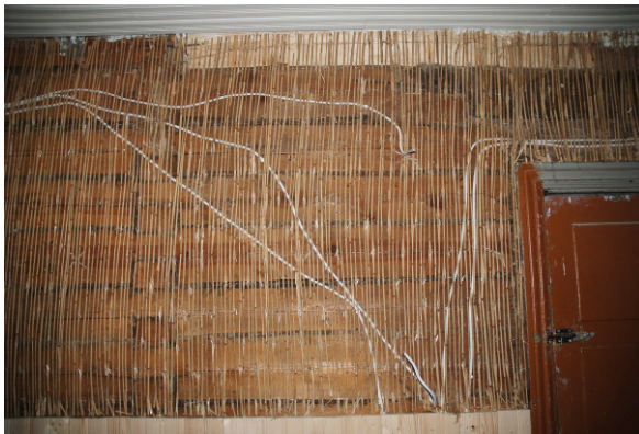
Joonis 10.6 Uus krohvialune kaabeldus on paigaldatud „risti-rästi“ üle seina ja hiljem on ohtlik seinale millegi kinnitamiseks auku puurida.
