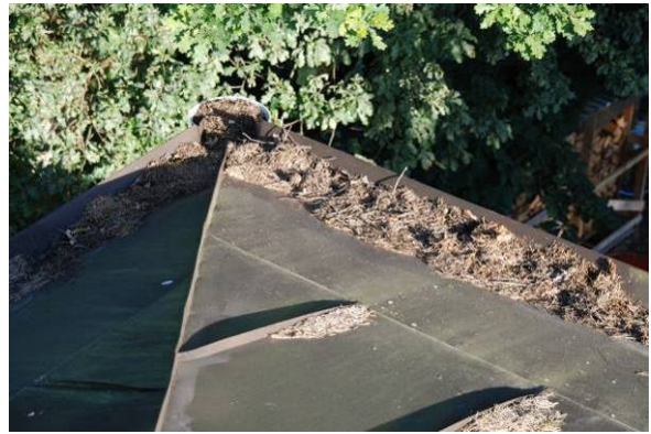
Joonis 2.17 Sademeveerennide ummistumine takistab vee ärajuhtimist katuselt.
