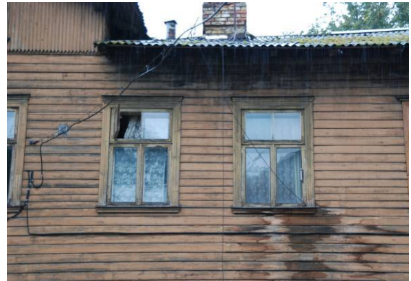
Joonis 2.29 Madalas soklist tingitud veekoormusest lagunenuid puitsõrestiksein. Kõrge kõnniteetasapind on kaotanud sokli ja puitsein on niiskes pinnases.
