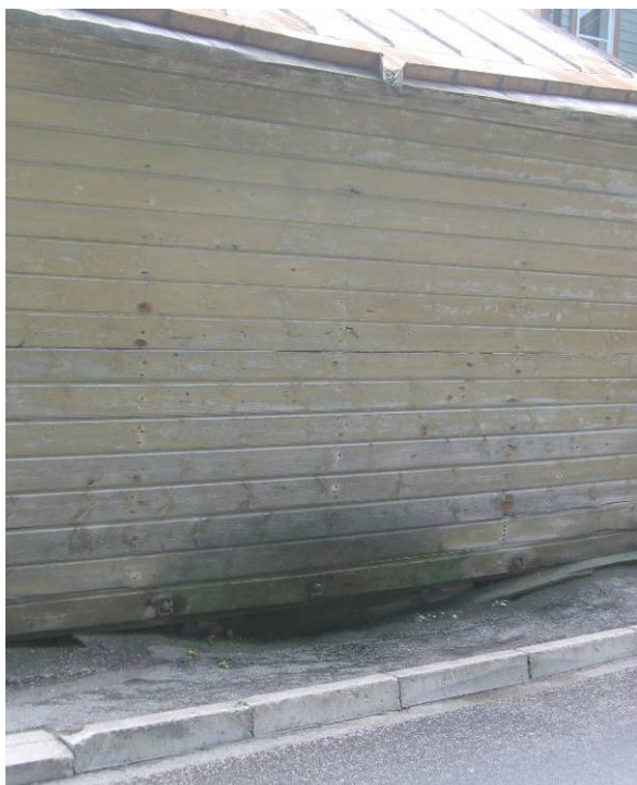
Joonis 2.16 Vihmaveetoru puudumisest põhjustatud välisseina ja pinnase ärauhutamine (vasakul) ja soklikahjustus (paremal). Vasakpoolsel fotol on näha fassaadilaudise paiknemine lubamatult maapinna lähedal.
