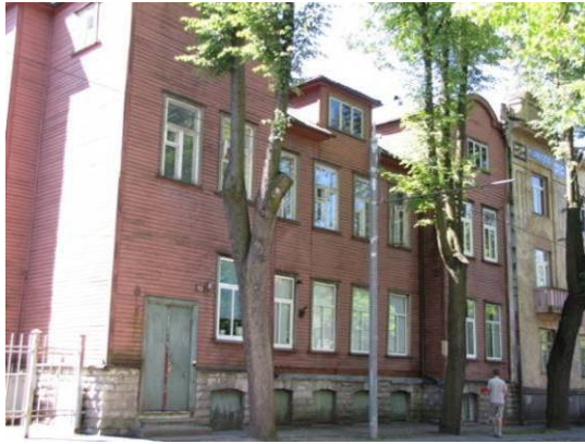
Joonis 2.25 Puitlaudisega fassaad (vasakul) ja krohvitud fassaad (paremal).
