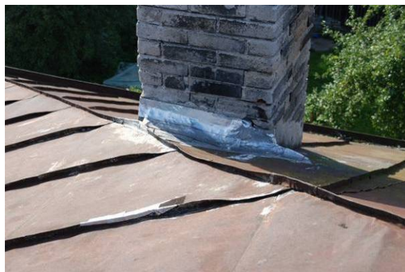
Joonis 2.7 Plekk-katuste lekkimise ja lagunemise peamised põhjused: katusekatte korrosioon, lekkes valtside ja liidete juures.
