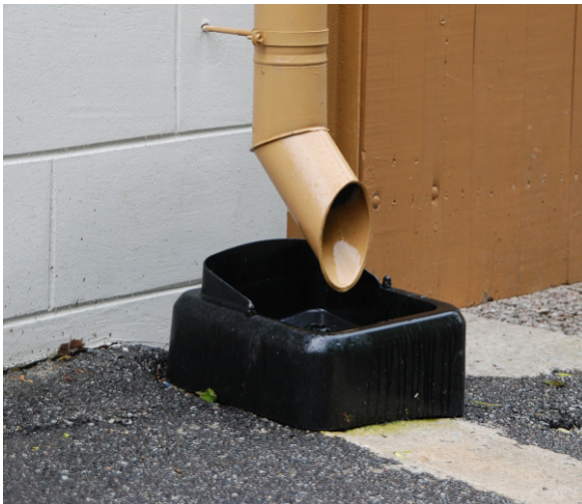
Joonis 13.14 Korrekselt lõpetatud vihmaveetoru.
