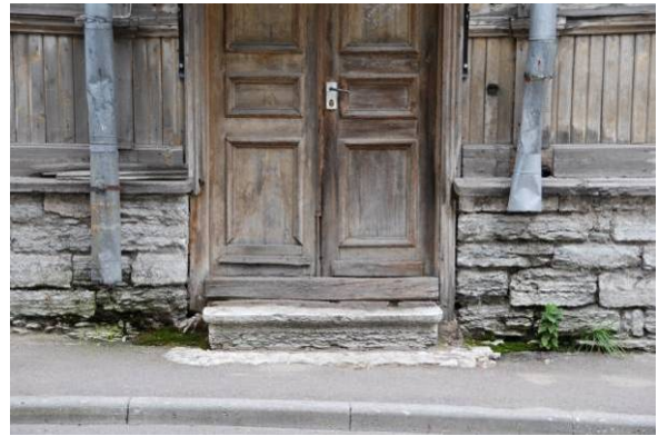
Joonis 2.18 Tänaväärsed sademeveetorud võivad sattuda vandalismi ohvriks.
