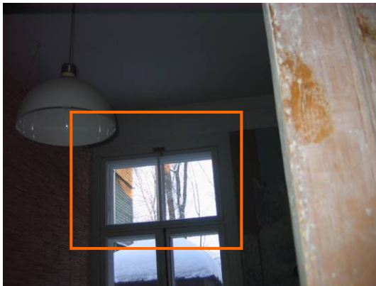
Joonis 3.5 Oluline külmasild uue kitsas lengis akna ja välisseina liitekohas, paremal termopilt normaalrõhu juures, vasakul on näha samast kohast tehtud foto.
