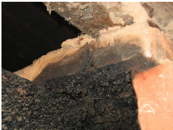
Joonis 10.2 Palkseina all oleva ahju tellis on praoga (vasakul), mistõttu on tahmunud ka palk (paremal). Tegemist on äärmiselt tuleohtlikku olukorraga, aga eemalt toa tasapinnalt jääb see märkamata.
