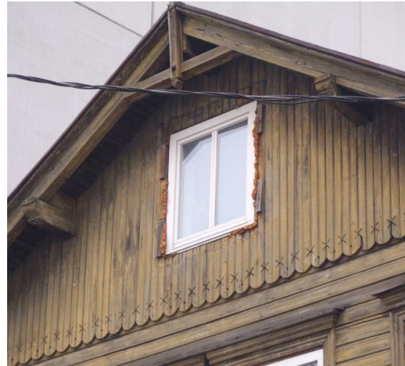
Joonis 9.9 Selle keldri saneerimine läheb majaomanikule väga kalliks maksma. Majavamm on tunginud suures ulatuses paekivivundamendi vuukide sisse ning selle eemaldamine on ränk ja ebaefektiivne töö, kui sellega ei kaasne vundamendi lahtikaevamist väljastpoolt (vasakul). Tähelepanuväärne on majaomanike hoolimatus akende vahetamisel. Energiat jätkub vaid uue akna paigaldamiseks, kui aknaümbrus jäetakse viimistlemata. Polüuretaanvaht laguneb päikese käes mõne aastaga ning akende lengide ja majaseina vahele tekib tühimik, mis on vee ja külma sissepääsu allikateks (paremal).
