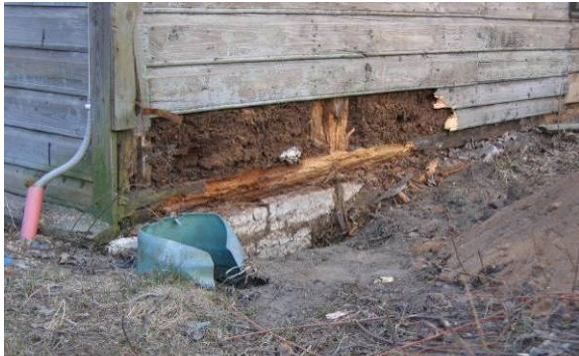
Joonis 2.29 Madalas soklist tingitud veekoormusest lagunenuid puitsõrestiksein. Kõrge kõnniteetasapind on kaotanud sokli ja puitsein on niiskes pinnases.
