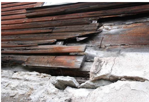
Joonis 2.36 Selline laudvooder (ja võimalik, et ka selle taga olev seinapalk) tuleb kiiremas välja vahetada.
