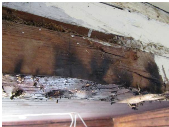
Joonis 10.2 Palkseina all oleva ahju tellis on praoga (vasakul), mistõttu on tahmunud ka palk (paremal). Tegemist on äärmiselt tuleohtlikku olukorraga, aga eemalt toa tasapinnalt jääb see märkamata.
