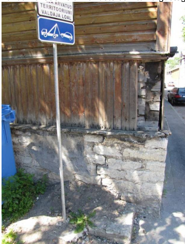
Joonis 2.45 Soklit on parandatud. Puitvooder tuleb samuti parandada, et kaitsta palke (vasakul). Sillutisriba peab olema kaldega hoonest eemale (paremal).
