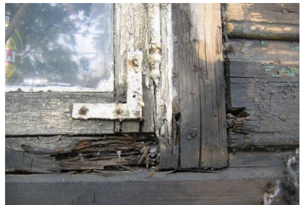
Joonis 2.31 Aknaalune piirkond oli seinte alaosa kõrval üheks teiseks enim kahjustunud piirkonnaks.
