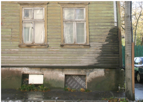
Joonis 2.29 Madalas soklist tingitud veekoormusest lagunenuid puitsõrestiksein. Kõrge kõnniteetasapind on kaotanud sokli ja puitsein on niiskes pinnases.
