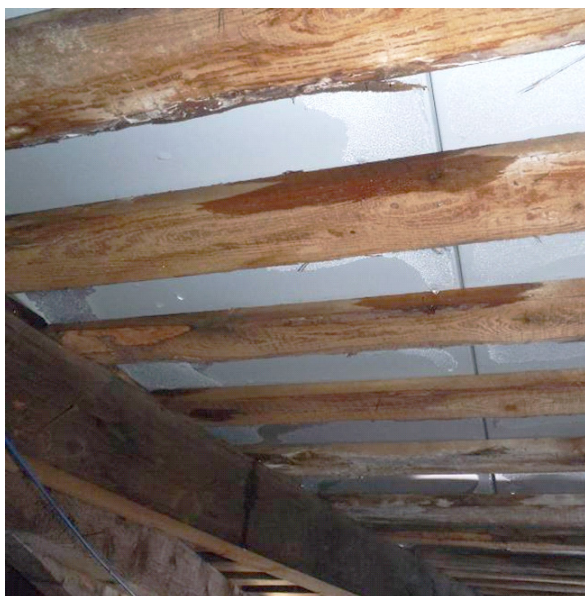
Joonis 9.8 Allajahtunud plekile kondenseerunud õhuniiskus koguneb tilkadeks ning pööningul "sajab" vihma, mis märgab vahelage ja tekitab seal seenkahjustust (vasakul). Asjatundmatult remonditud duširuumi põrand teisel korrusel on põhjustanud ulatusliku veejooksu vahelae sisse ning tekitanud soodsad tingimused majavammide arenguks. Majavamm ei oleks selles kohas kasvama hakanud, kui keldris poleks juba eelnevalt olnud ulatuslikku majavammide kahjustust koos eoste laialikandumisega (paremal).
