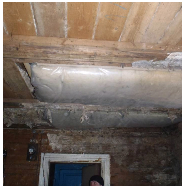
Joonis 9.8 Allajahtunud plekile kondenseerunud õhuniiskus koguneb tilkadeks ning pööningul "sajab" vihma, mis märgab vahelage ja tekitab seal seenkahjustust (vasakul). Asjatundmatult remonditud duširuumi põrand teisel korrusel on põhjustanud ulatusliku veejooksu vahelae sisse ning tekitanud soodsad tingimused majavammide arenguks. Majavamm ei oleks selles kohas kasvama hakanud, kui keldris poleks juba eelnevalt olnud ulatuslikku majavammide kahjustust koos eoste laialikandumisega (paremal).
