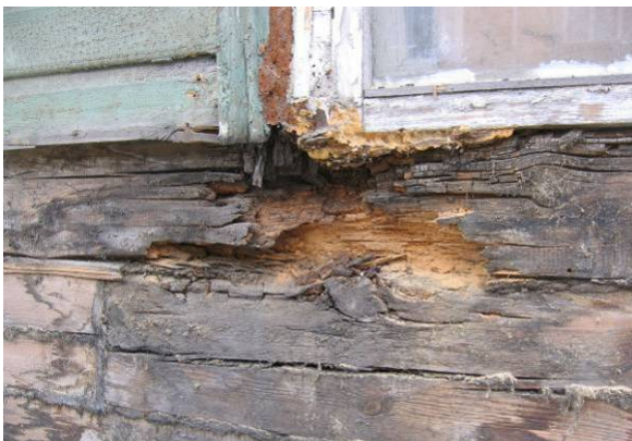
Joonis 2.31 Aknaalune piirkond oli seinte alaosa kõrval üheks teiseks enim kahjustunud piirkonnaks.
