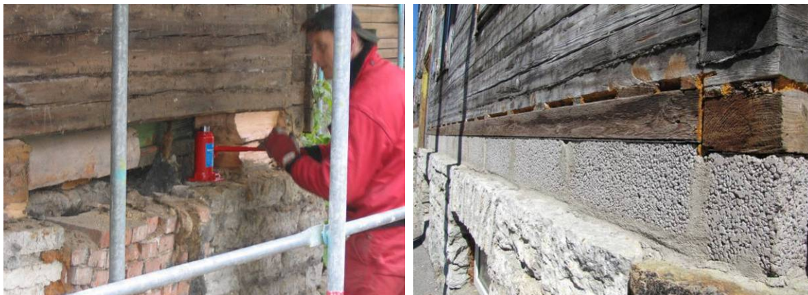
Joonis 13.9 Seina alumiste palkide asendamine keramsiitplokkmüüritisega on lahendus, mida korraliku kõrge sokliga majadel tuleks pigem vältida.
