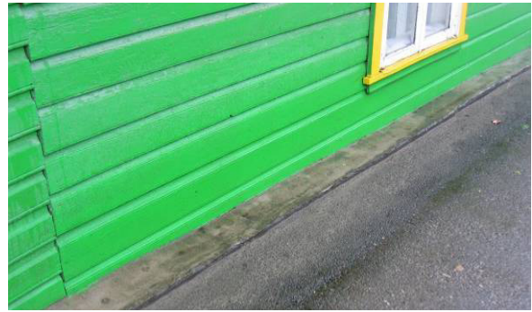
Joonis 2.29 Madalas soklist tingitud veekoormusest lagunenuid puitsõrestiksein. Kõrge kõnniteetasapind on kaotanud sokli ja puitsein on niiskes pinnases.
