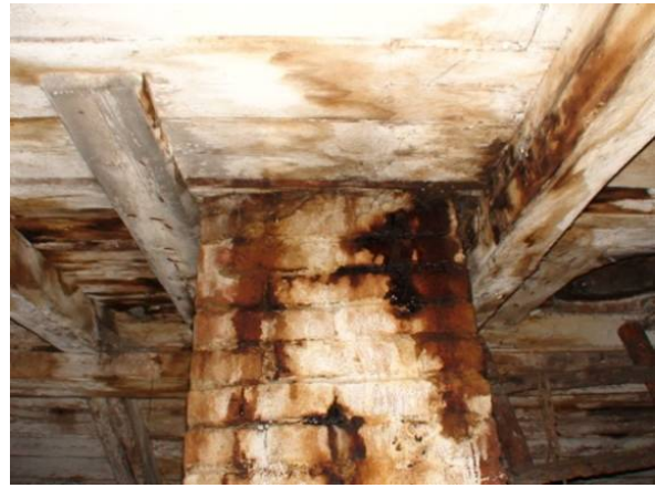
Joonis 2.71 Puitkonstruktsioonid ei tohi olla vastu korstnat. Minimaalne distants on 10 cm (või rohkem sõltuvalt küttevõimsusest ja korstna lahendusest) isoleerituna tuletõkke mineraalvillaga (kivi- või klaasvill).
