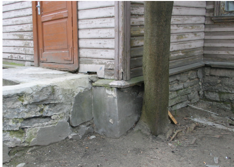
Joonis 2.50 Puu kasvab vundamendile liiga lähedal.
