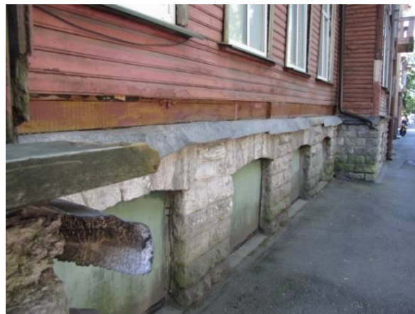
Joonis 2.48 Veelaua laius 10 cm, sokli üleulatus ca 5 cm (vasakul), veelaud puudub. See soodustab alumiste palkide märgumist (paremal)
