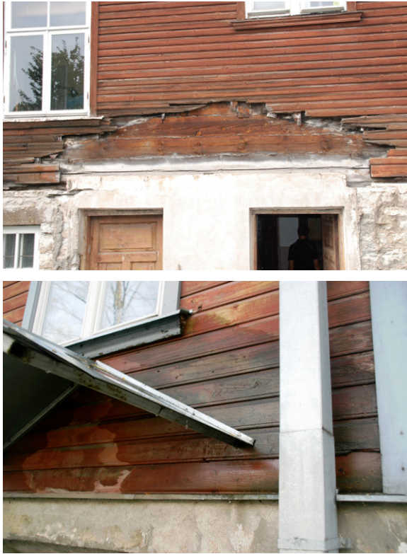
Joonis 2.22 Varikatusest põhjustatud kahjustused välisseinal.
