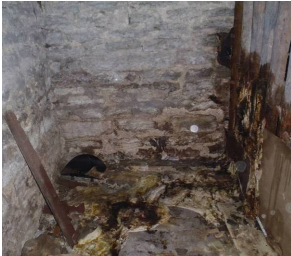
Joonis 9.9 Selle keldri saneerimine läheb majaomanikule väga kalliks maksma. Majavamm on tunginud suures ulatuses paekivivundamendi vuukide sisse ning selle eemaldamine on ränk ja ebaefektiivne töö, kui sellega ei kaasne vundamendi lahtikaevamist väljastpoolt (vasakul). Tähelepanuväärne on majaomanike hoolimatus akende vahetamisel. Energiat jätkub vaid uue akna paigaldamiseks, kui aknaümbrus jäetakse viimistlemata. Polüuretaanvaht laguneb päikese käes mõne aastaga ning akende lengide ja majaseina vahele tekib tühimik, mis on vee ja külma sissepääsu allikateks (paremal).
