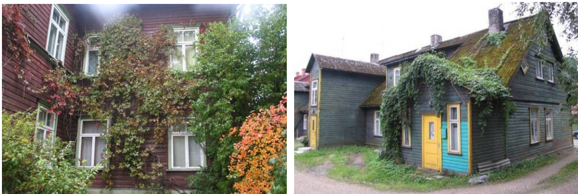
Joonis 2.34 Sammal ja ronitaimed ei mõju hästi puitkonstruktsioonide kestvusele.
