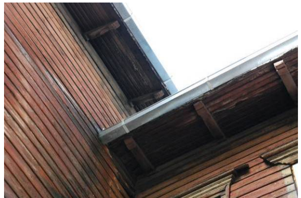
Joonis 2.19 Sademeveerennist seinale valguva vee korral satub välissein suure veekoormuse alla.
