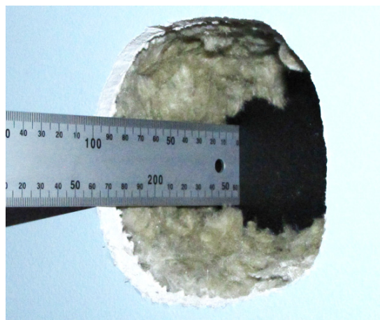
Joonis 5.27 Seinä kõverusest tulenevalt varieerus soojustuse paksus seinas 50...90 mm vahel.
