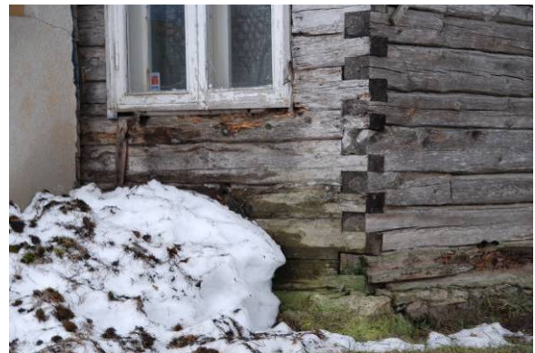
Joonis 2.30 Välisseina niiskuskahjustuste allikad: vee valgumine seinale vihmavee torust, antennikaabli kaudu, lumesulamisvee valgumine seinale.
