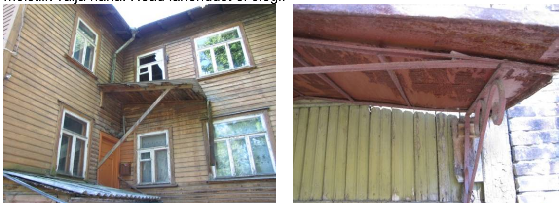
Joonis 2.21 Varikatuse hoone sisenurgas, millele kogunev lumi ja vesi kahjustavad ka külgnavaid seinu (vasakul). Õhukesest plekist varikatusest on läbi roostetanud (paremal).
