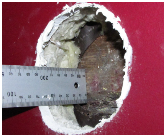
Joonis 5.27 Seinä kõverusest tulenevalt varieerus soojustuse paksus seinas 50...90 mm vahel.
