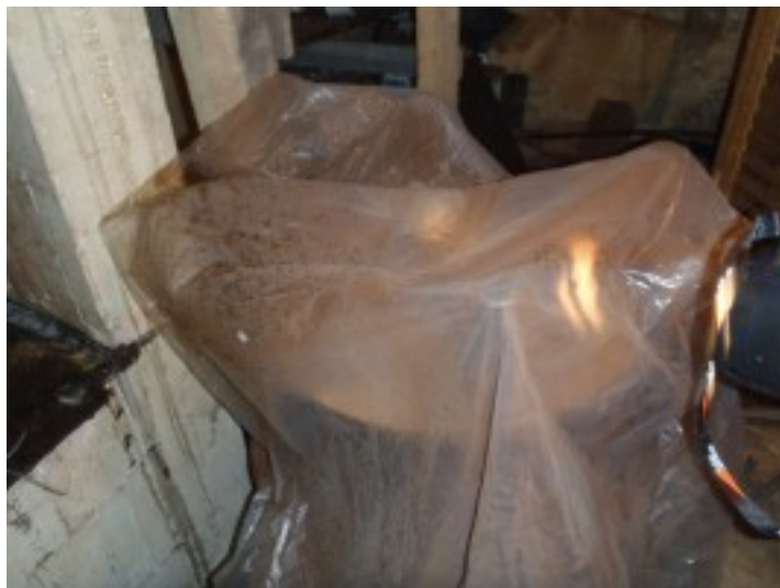
Joonis 9.12 Majavammi pruuni värvi eoste kiht katab silmnähtava kihiga kõiki kahjustuse piirkonnas olevad esemeid.
