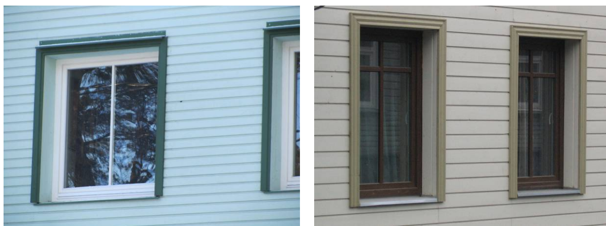
Joonis 2.65 Puitkorterelamule sobimatu lahendus: fassaadipinnas aukus plastaken.
