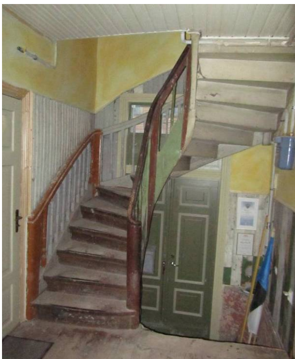
Joonis 2.60 Levinud trepilahendus väiksemates puitkorterelamutes: kahekäiguline keerdastmetega trepp.
