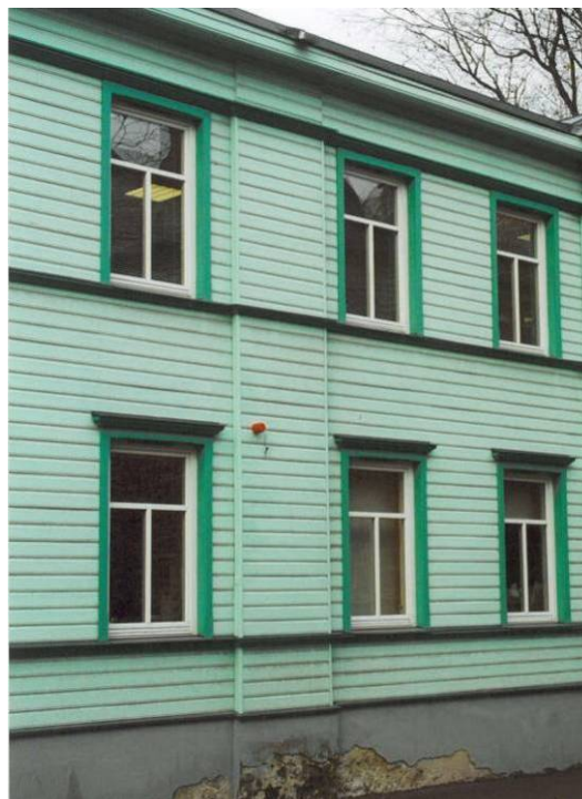
Joonis 2.16 Vihmaveetoru puudumisest põhjustatud välisseina ja pinnase ärauhutamine (vasakul) ja soklikahjustus (paremal). Vasakpoolsel fotol on näha fassaadilaudise paiknemine lubamatult maapinna lähedal.
