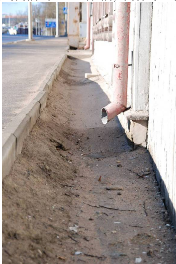
Joonis 2.46 Tänavapind ulatub üle keldri akna ülemise serva ja veelaua.
