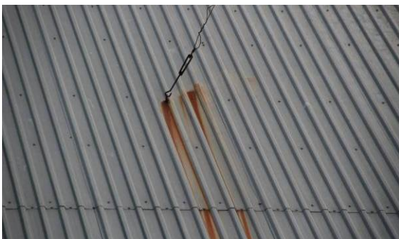
Joonis 2.7 Plekk-katuste lekkimise ja lagunemise peamised põhjused: katusekatte korrosioon, lekkes valtside ja liidete juures.
