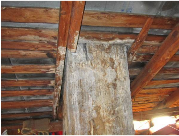
Joonis 2.71 Puitkonstruktsioonid ei tohi olla vastu korstnat. Minimaalne distants on 10 cm (või rohkem sõltuvalt küttevõimsusest ja korstna lahendusest) isoleerituna tuletõkke mineraalvillaga (kivi- või klaasvill).
