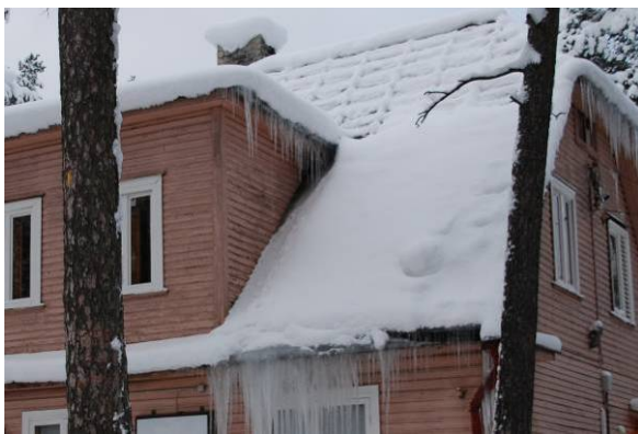
Joonis 2.11 Mitme meetri pikkused jääpurikad viitavad katuse või pööningu vahelae puudulikule soojustusele.
