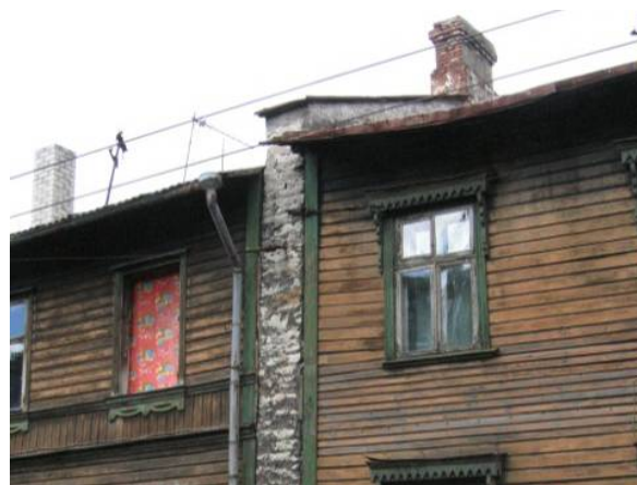
Joonis 2.70 Katusekandekonstruktsioonid on lubjatud, et vähendada nende süttivustundlikkust (vasakul). Tulemüür kokkuehitatud hoonete vahel (paremal).
