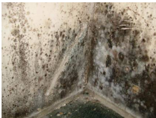
Joonis 9.4 Silmanähtav mikrobioloogiline kasv tapeedil, millest osa moodustas ka õhusaaste sh. tahm.
