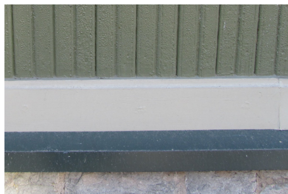
Joonis 13.4 Sokli renoveerimise põhimõtteline skeem (vasakul). Üldiselt korrektselt renoveeritud sokkel; vaid fassaadivoodri taguse tuulutamine on jäetud tegemata, mis raskendab seina kuivamist (paremal).
