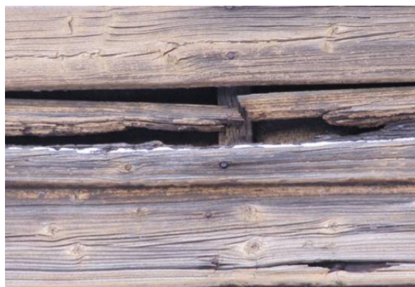
Joonis 2.36 Selline laudvooder (ja võimalik, et ka selle taga olev seinapalk) tuleb kiiremas välja vahetada.
