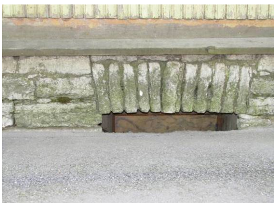
Joonis 2.46 Tänavapind ulatub üle keldri akna ülemise serva ja veelaua.
