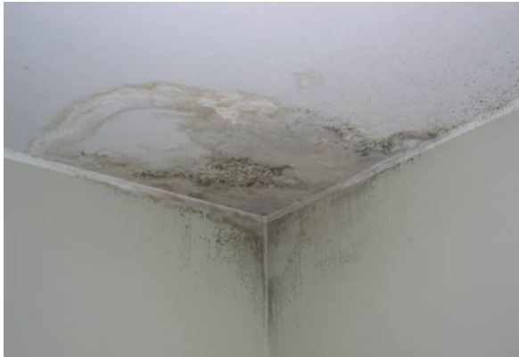
Joonis 2.10 Katuse läbijooksudest põhjustatud kahjustused ülemise korruse laes (vasakul). Katuse läbijooksu tagajärgi on püütud vähendada veeanumate ja pööningu põrandale laotatud kilede abil, kuid see teeb tagajärjed veelgi halvemaks.
