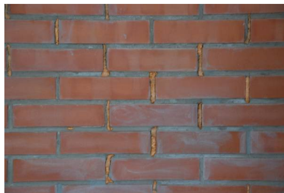
Joonis 10.3 Ahjumüüri tühjade püstvuukide ja pragude lubamatu täitmine montaažvahuga.
