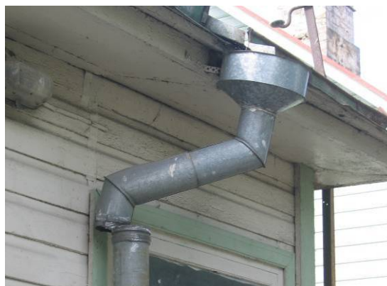
Joonis 2.15 Katkenud vihmaveetoru korral satub välissein suure veekoormuse alla.
