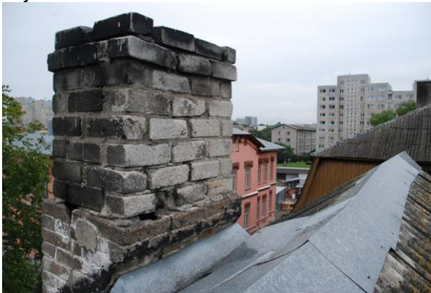
Joonis 2.72 Lagunenud korsten tuleb viivitamatult renoveerida.
