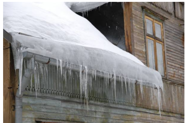
Joonis 2.11 Mitme meetri pikkused jääpurikad viitavad katuse või pööningu vahelae puudulikule soojustusele.
