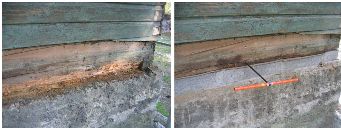
Joonis 13.10 Seina alumiste palkide (vasakul) osaline (~10 cm) asendamine keramsiitplokkmüüritisega ja proovide võtmine säilinud puidust (paremal).
