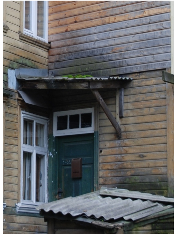
Joonis 2.22 Varikatusest põhjustatud kahjustused välisseinal.
