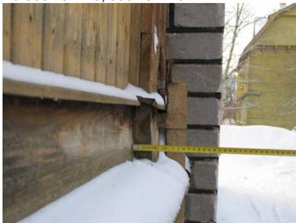
Joonis 2.48 Veelaua laius 10 cm, sokli üleulatus ca 5 cm (vasakul), veelaud puudub. See soodustab alumiste palkide märgumist (paremal)
