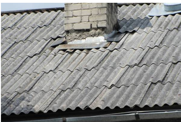
Joonis 2.8 Peamised lekkkohad katuste läbiviikude juures: antennikinnitused, katuseluugid, korstnad.
