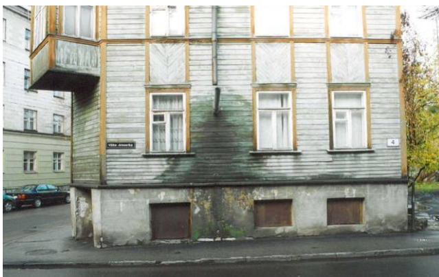
Joonis 2.15 Katkenud vihmaveetoru korral satub välissein suure veekoormuse alla.
