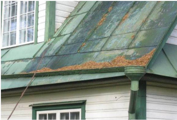
Joonis 2.17 Sademeveerennide ummistumine takistab vee ärajuhtimist katuselt.
