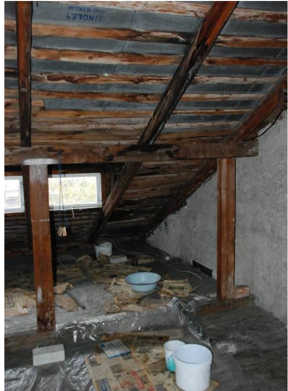
Joonis 2.10 Katuse läbijooksudest põhjustatud kahjustused ülemise korruse laes (vasakul). Katuse läbijooksu tagajärgi on püütud vähendada veeanumate ja pööningu põrandale laotatud kilede abil, kuid see teeb tagajärjed veelgi halvemaks.
