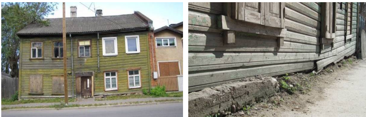
Joonis 2.28. Hoone on ebaühtlaselt vajunud
