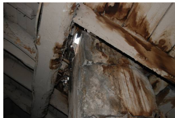
Joonis 2.8 Peamised lekkkohad katuste läbiviikude juures: antennikinnitused, katuseluugid, korstnad.
