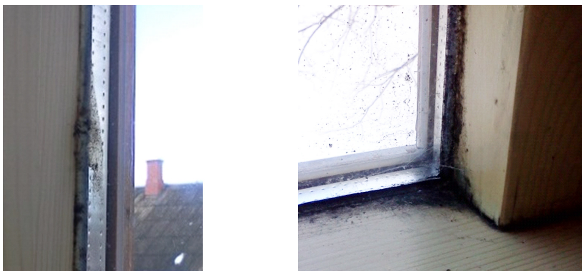
Joonis 9.6 Hallitused kasvavad eranditult silikooniriba peal (vasakul). Hallitused on levinud silikoonilt puidust aknapõse ja aknalaua peale (paremal).
