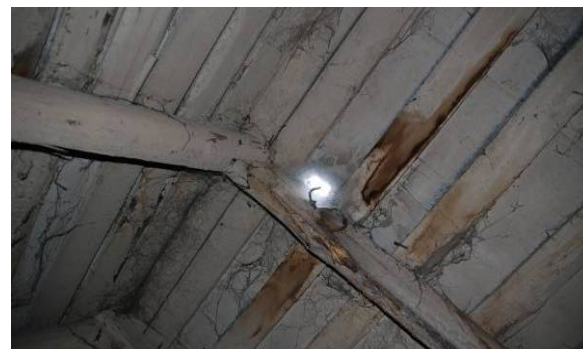
Joonis 2.7 Plekk-katuste lekkimise ja lagunemise peamised põhjused: katusekatte korrosioon, lekkes valtside ja liidete juures.
