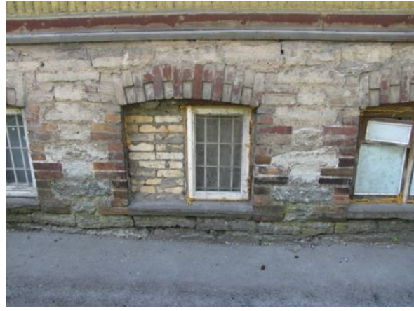
Joonis 2.66 Maapinna tasandil olevad aknad on tihti lõhutud või lagunenud suure veekoormuse tõttu.
