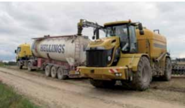
Joonis 5.12. Ümberpumpamine liikurlaoturi pumpamissüsteemiga (Tamm, K.)
