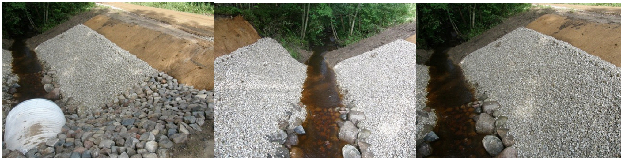
Kombineeritud kivikindlustus geotekstiilil ja geokärg killustik täitega RMK objektil.
