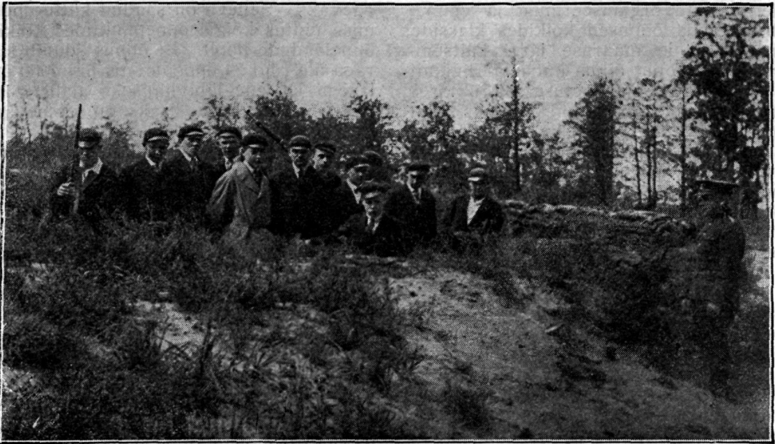
Välikindlustustöödel. (Vestholmi gümn. 3-b kl., 31. V 1930.)
