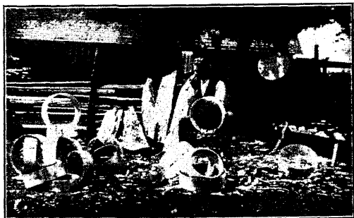
Avinurme Mõisaküla „Välja“ talu külimitööstus.
