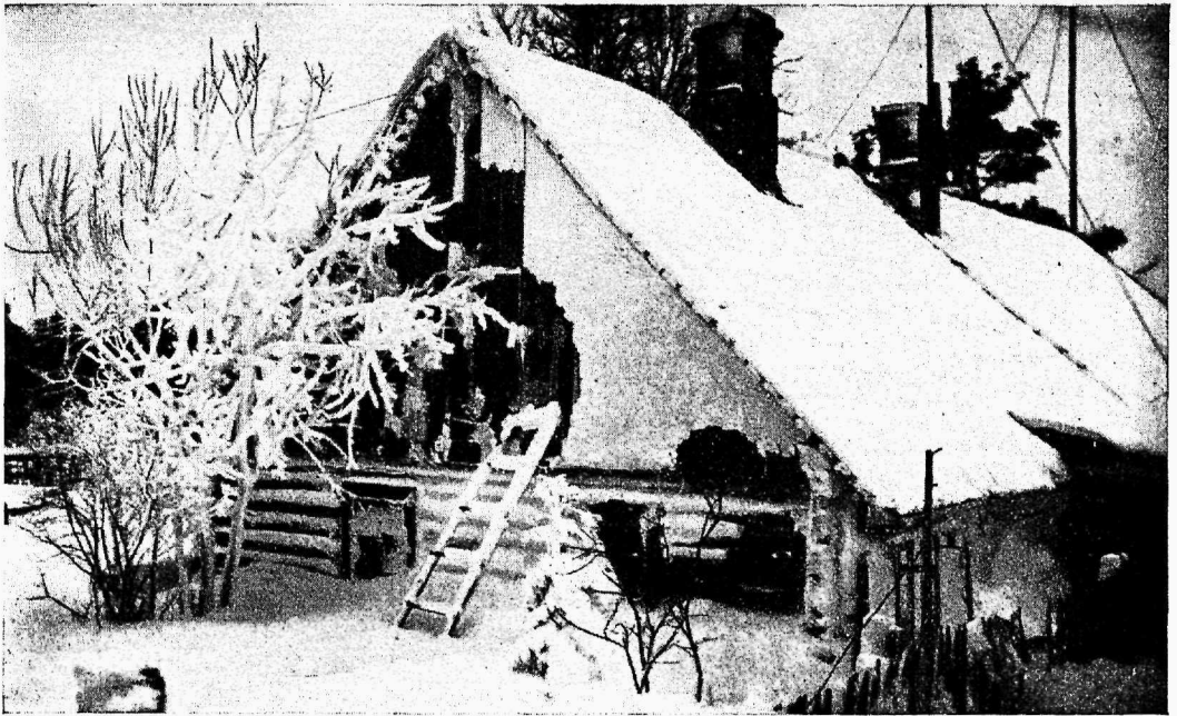
Lumega kattunud hoone Naissaarel
