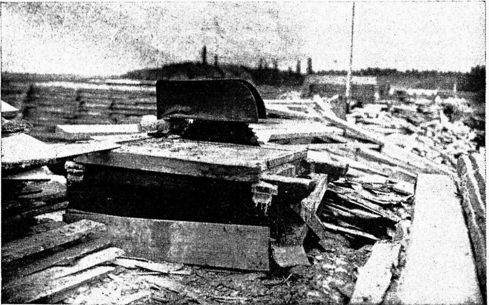
Kreissaaug lauaserude kalkilõikamiseks. Saag on kaitseta ja töökoht lubamatult korratutes.
