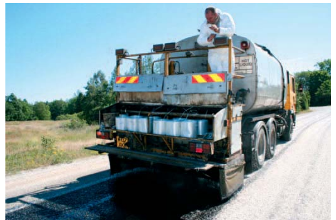
Cola Ltd kiudpindamismasin 25. juulil 2006 Jõelähtme-Kemba teel töös
