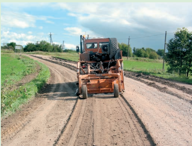
Kruusatee tasasena hoidmiseks tuleb neid sageli hõõveldada, vajadusel kruusa lisada, hooldus maksab võrreldes asfalkattega enamgi. Pildil: kruusatee näidisremont PÖMA (Saksa) seadmetega, 2004 (Vi TL 2(38)). Fotod: E. Vahter
