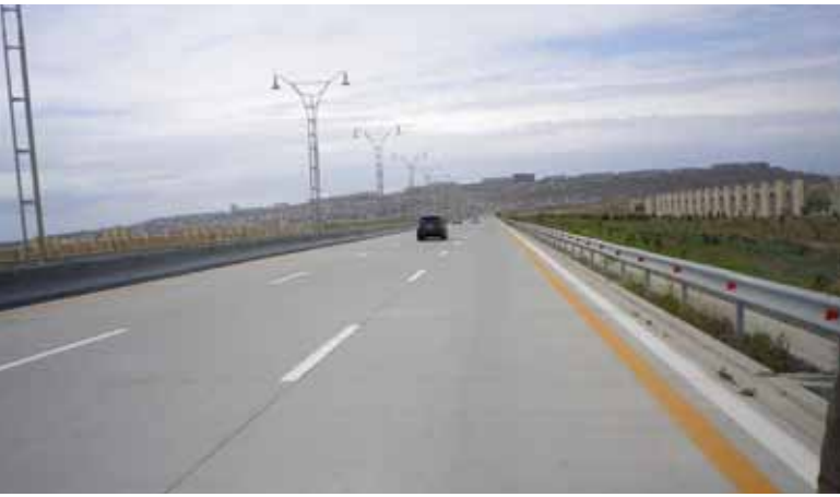
Kiirtee (betoonkattega) Baku lennujaama
