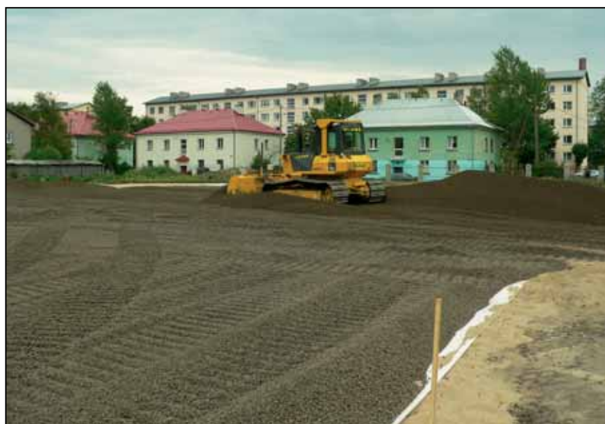
KERGGKRUUSA LAOTAMINE GEOTEKSTIILIGA KAETUD LIIVAKIHILE
