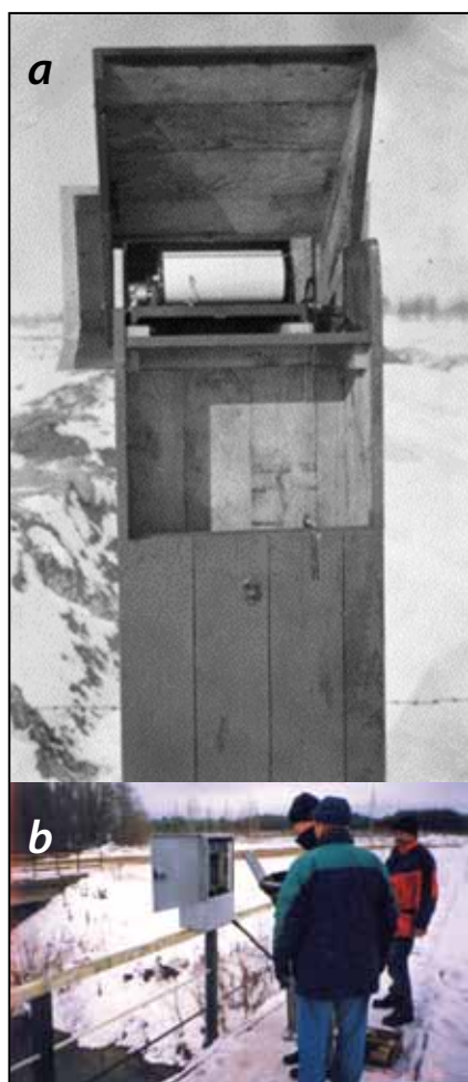
JOONIS 1. a ON VEETASEME ISEKIRJUTI 1928. AASTAST NING b MOODNE VOOLUHULGA MÄÄRAMISE AUTOMAATJAAM
