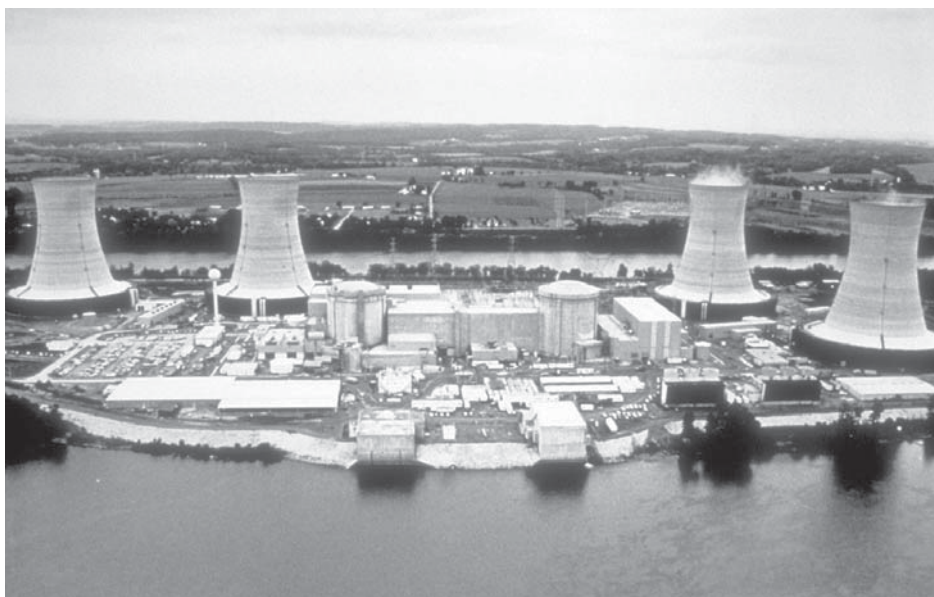
Joonis 1. Three Mile Island tuumajaam oma kahe reaktori ja nelja jahutustorniga
