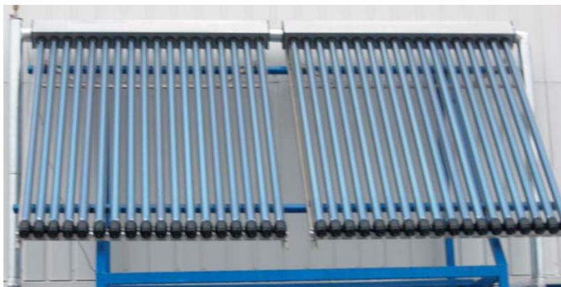
Joonis 2. Eestis kasutatav Hiina päritolu vaakumtorukollektor SPA-58-1800
