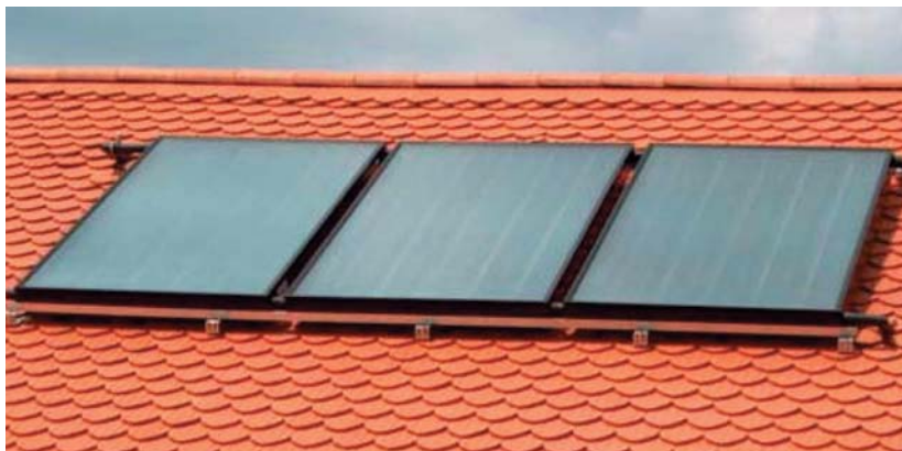
Joonis 1. Austria firma Sonnenkraft Eestis kasutatav lame heliokollektor SK 500
