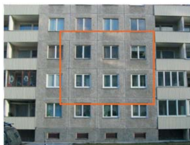
Suurpaneelilamute välispiiretesse projekteeritud ja ehitatud külmasildade likvideerimiseks on lisasoojustamine hädavajalik
