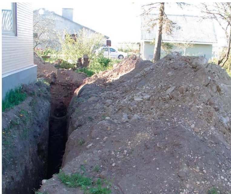
Foto 2. Lahtikaevatud vundamenditagune
