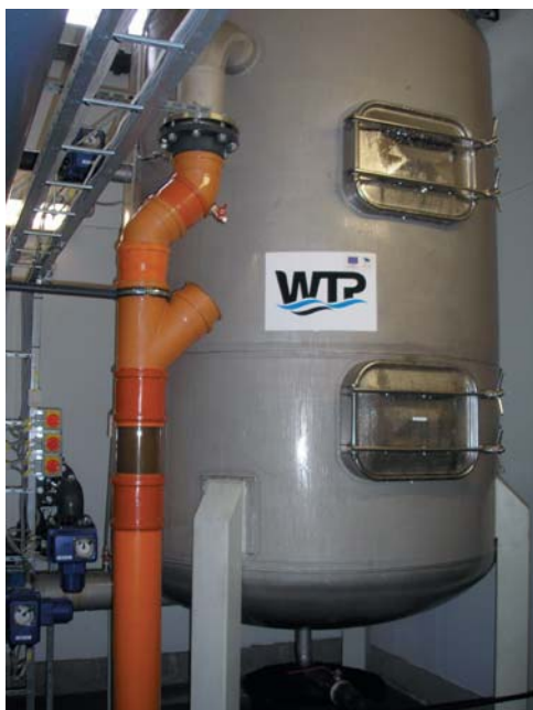
Foto 1. Mähe puurkaevupumpla katalüütilise täidisega filter
