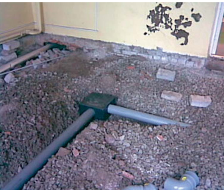
Foto 1. Põrandaalune radoonikogur ja radooni ära juhtivad torud enne killustikuga katmist
