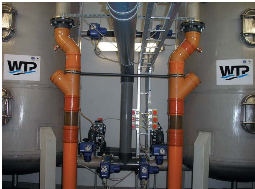
Foto 2. Kaks üheastmelist, elektriliselt reguleeritavate klappidega filtrit
