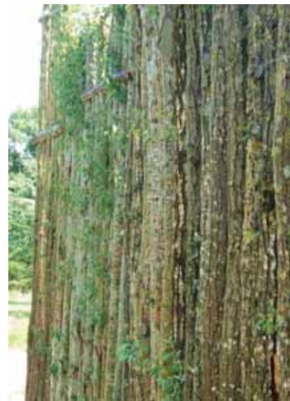
Joonis 3. Sinnovegi looduslik müratõkkesein Foto: Sinnoveg
