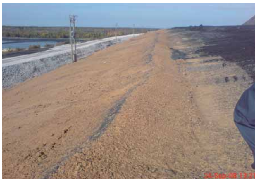
Kohtla-Järve poolkoksimaagi Soil Guard-iga kaetud nõlv ja tõkestusvall
