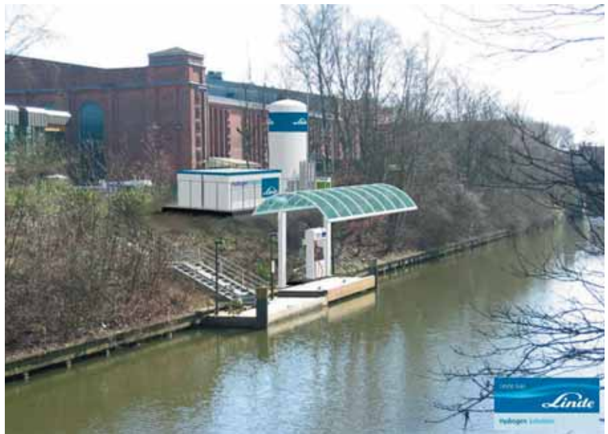
Joonis 3. Laeva FCS Altwasser jaoks ehitatud vesinikutankla Hamburgis
