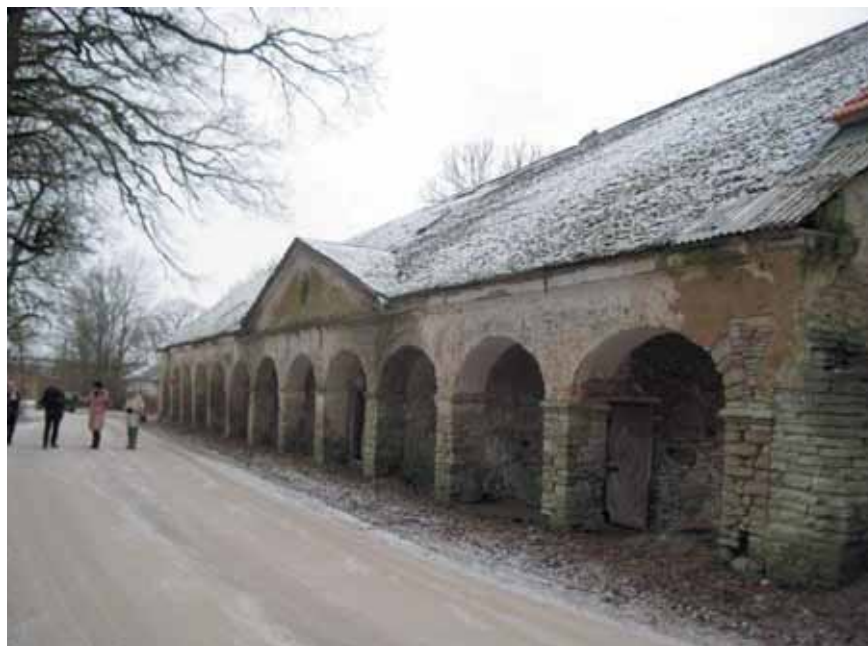
Muinsuskaitse alla võetud Raikküla mõisa aitkuivati Eesti pikima võlvkaaristu sammastega on ehitatud Raikküla lademe õhukese kihilisest lubjakivist
