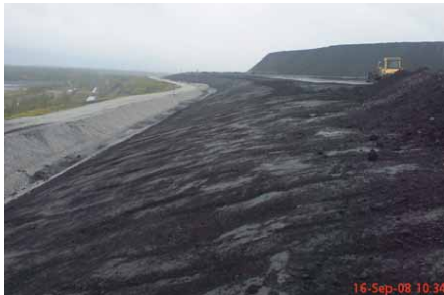
Kohtla-Järve poolkoksimaagi nõlv on katmiseks ette valmistatud
