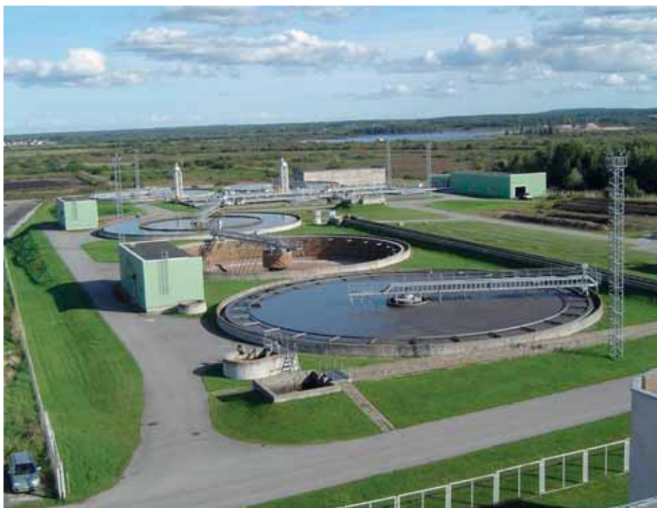
AS-i Tartu Vesi reoveepuhasti
