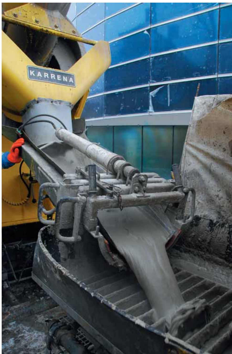
Vahtbetoonisegu on võimalik pumbata
