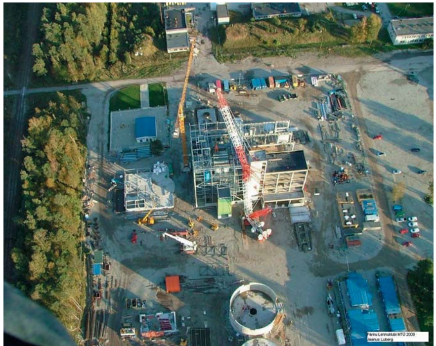
Pärnusse Niidu tänavale rajatavas koostootmisjaamas hakatakse turbast ja hakkpuidust tootma elektrit ja soojust
