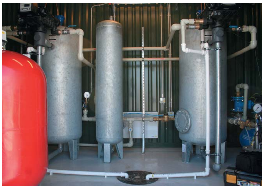
Keava asula veetöötlusseadmed EURA AIR (jõudlus 8,5 m 3 /h)
