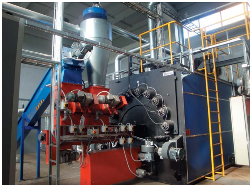
Biokütusekatel rohtse biomassi või hakkpuidu põletamiseks
