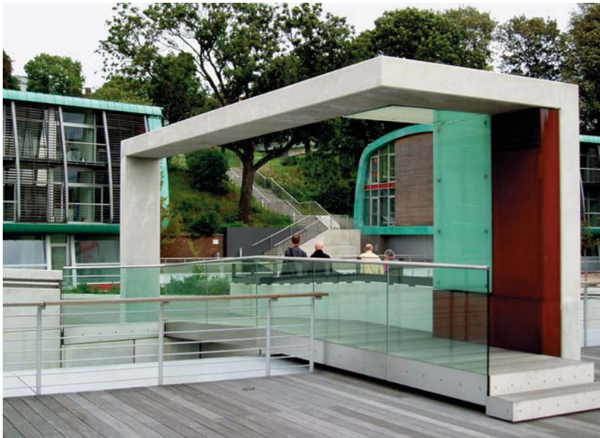
Näide ajakohasest linnaruumist Hamburgis, kus hoonete paigutuse läbitöötatus ja sobitus maastikuga kujundab elukeskkonna kvaliteedi. Hoonestuse paigutuse alused määrab planeering, hoone vormi arhitekti loomingulisus. Siin on näha koostöö sünergia
