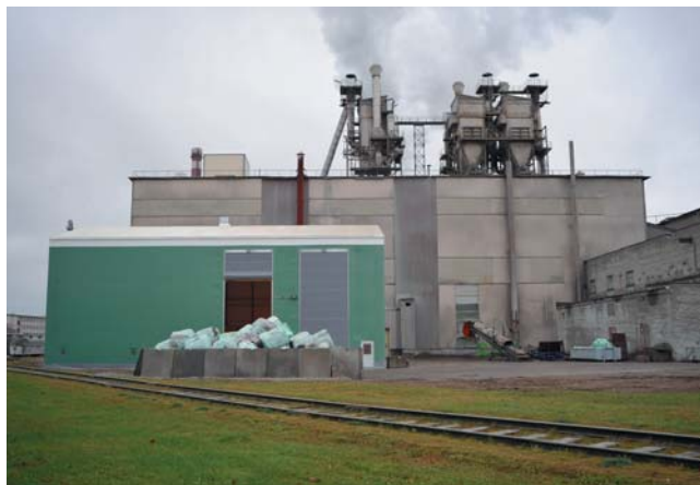
Jäätmekütuse vastuvõtusõlm ja laohoone Fotod: Kalle Kikas
