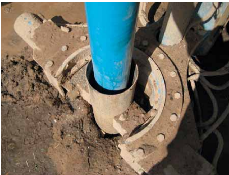
Joonis 4. Kahe rootoriga puurides on võimalik pudedat kivimit toetavat juhttoru, mis hiljem eemaldatakse, tsementimise ajaks maa sisse jätta
