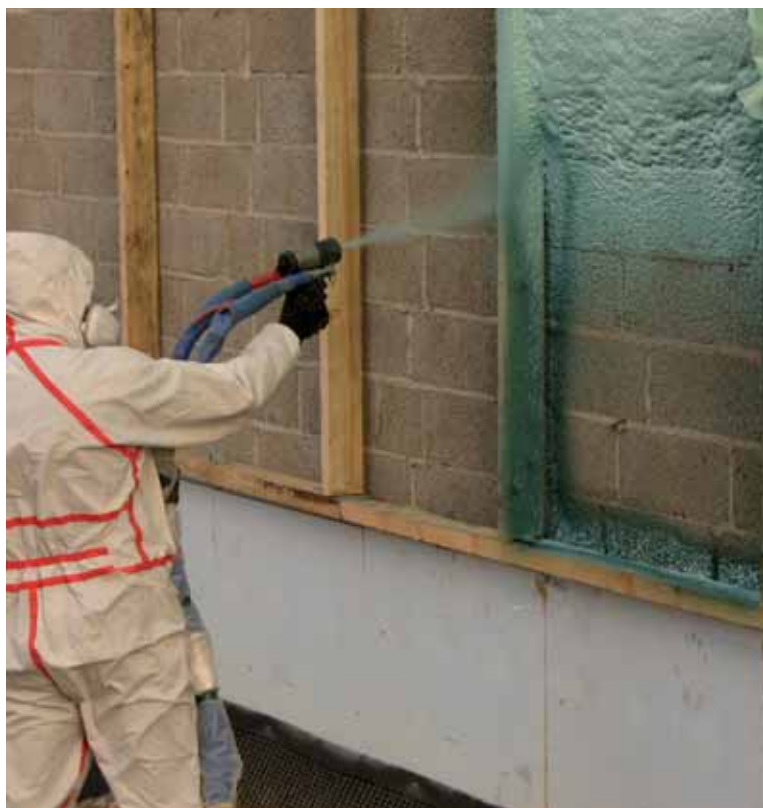
Joonis 3. PUR-soojustusvahu pihustamine
