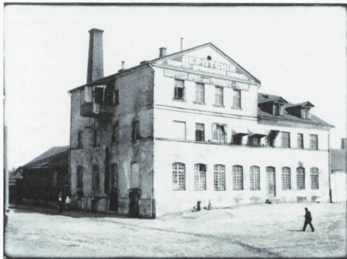
Johannes Pääsuke. Pärmivabrik Tartus. 1913 (?) Johannes Pääsuke. Factory in Tartu. 1913 (?)
