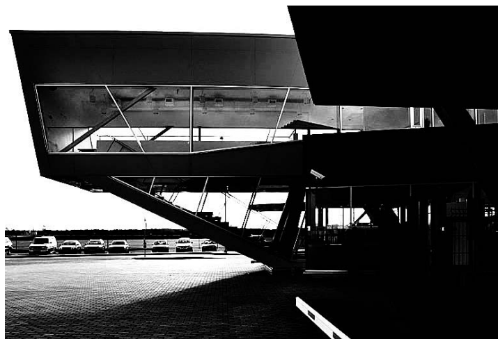
Sillamäe sadama Narva piiriületuseelse veoautode parkla pääslahoone. Autorid Andres Alver, Tarmo Laht, Ulla Saar, Indrek Rünkla (Alver Arhitektid). Valminud 2011. Foto: Alver Arhitektid.
