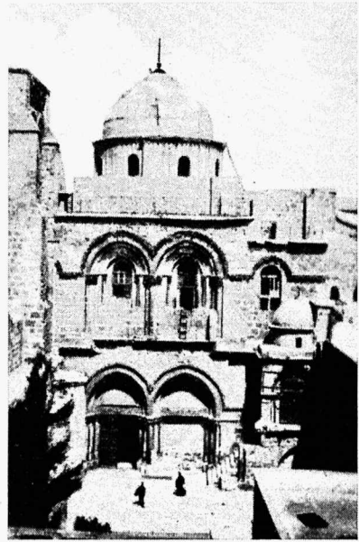
Kristuse hauakiriku fassaad.
