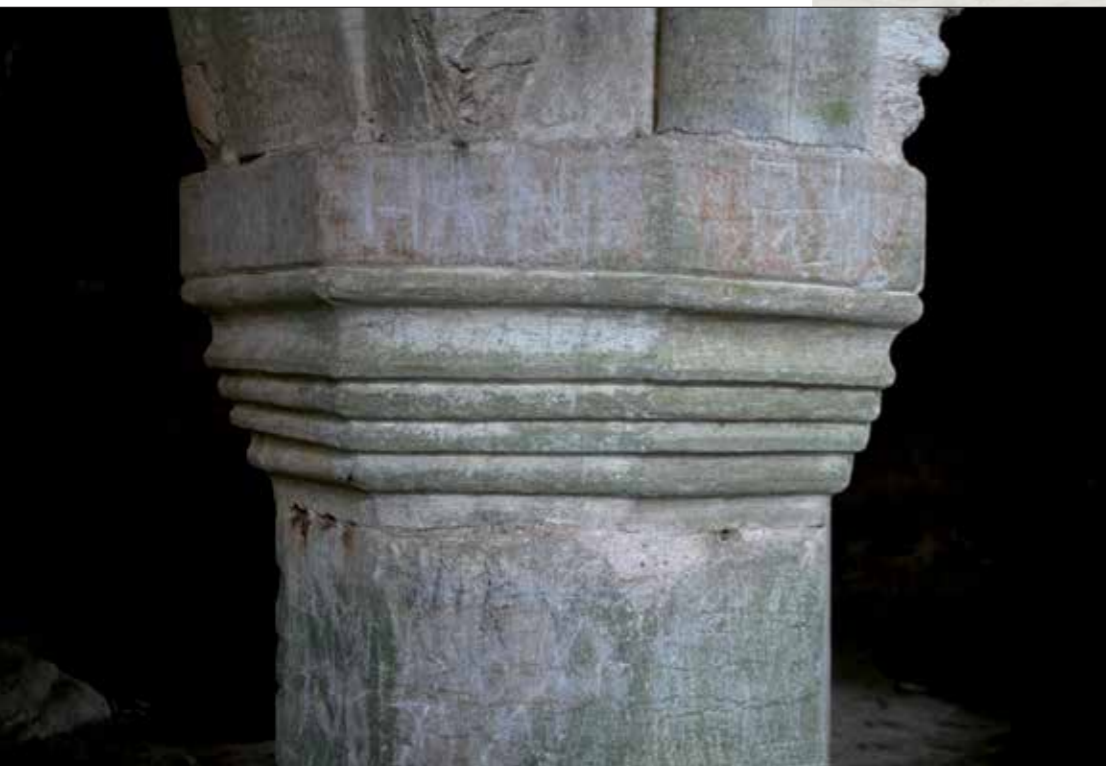
Joonis 3. Kelderkabeli piilari kapiteel (foto: Kaur Alttoa).
