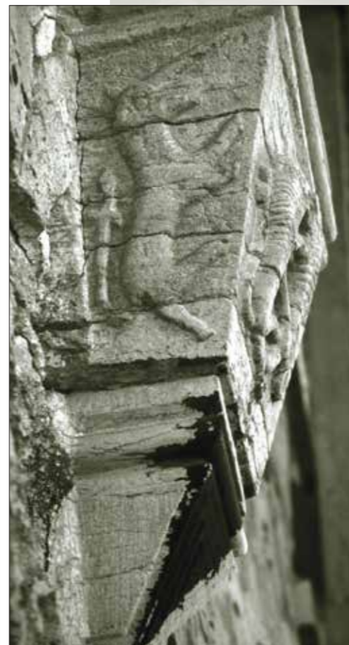
Joonis 5a ja b. Kiriku põhjaseina konsool (foto: Kaur Alttoa).
