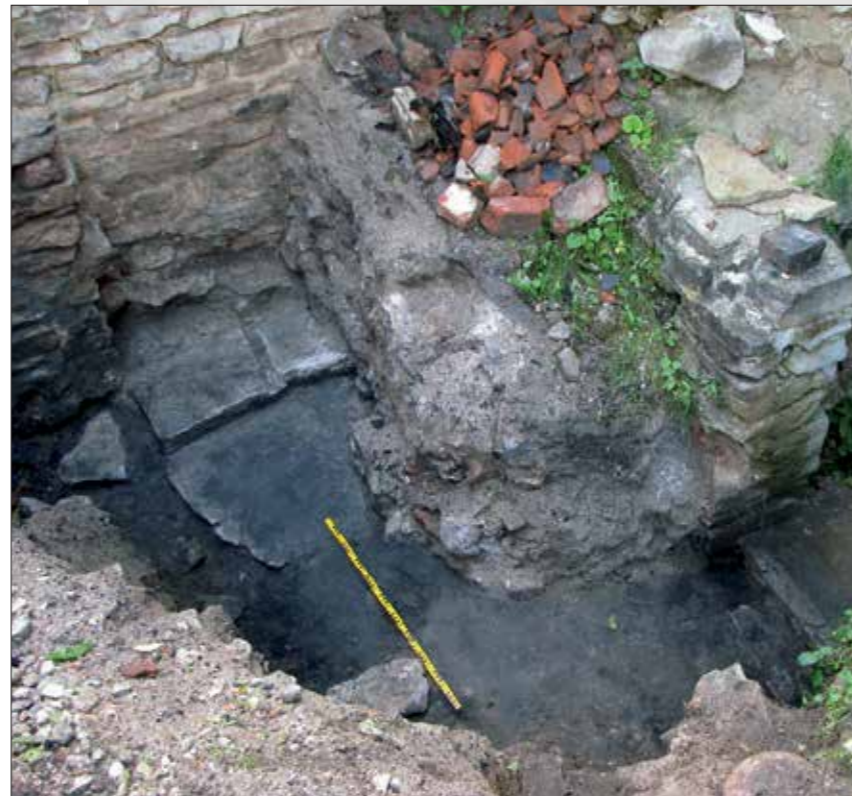
Joonis 22. Kaarniššidega hoone ruumi 010 edelaosa. Paremäl keldri ukseava kivipiidad, vasakul trepiastmed kinnimüüritud ukseava ees. Paremäl esiplaanil paistab pinnasest kivist suurtükikuul (foto: Villu Kadakas).
