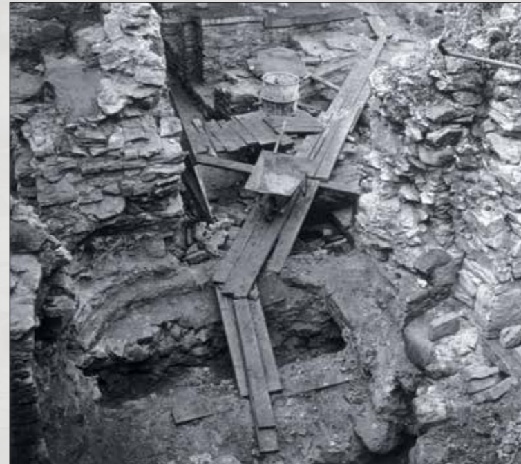
Joonis 18. Leivaahju jäänused enne lammutamist ja samal kohal paiknenud müüride restaureerimist 1962. aastal. Ülasosas lääneristikäigu jäänused ja sisehoov (foto: Villem Raam).
