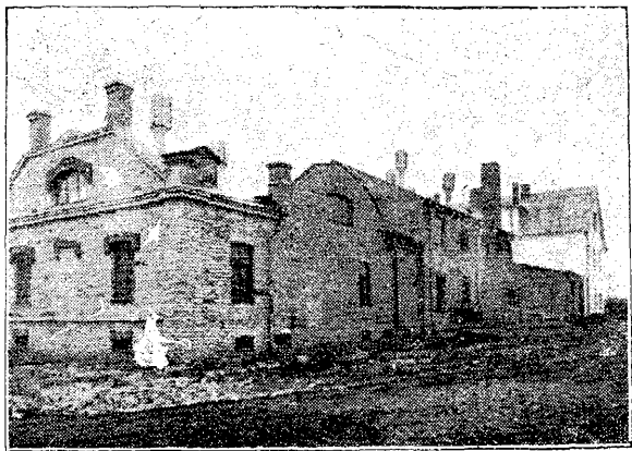
Taimevõitehas „Kokk'a“ lõunapoolne osa, milles asub võivalmimise ruum, ladu ja taimeraska sulatis ning piima ruumid, ka katlamaja ühes puurkaevuga.
