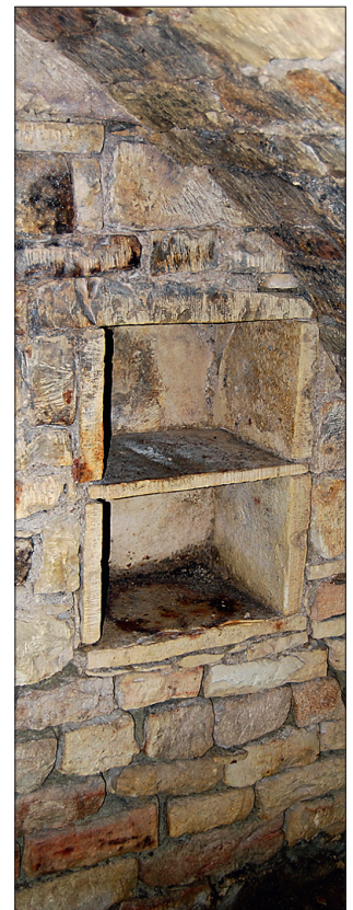
► Matsi talu keldris on säilinud ka müüritise sisse laotud kiviriulid.
