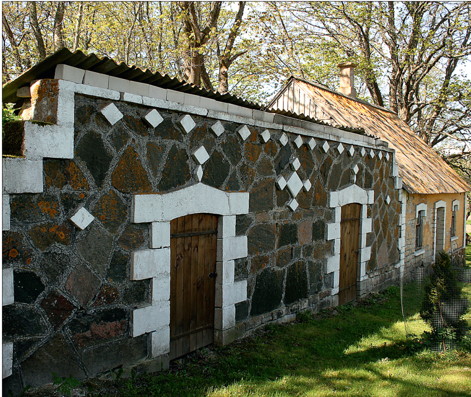
► Uhke kaheosaline kelder Muhumaal Pallasmaa külas Matsi talus on valminud aastal 1924.
