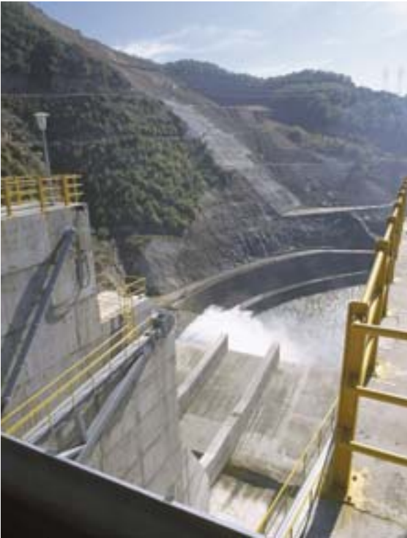
Piirideta hüdroelektrienergia: tamm Nestose jõel, Kreeka ja Bulgaaria vahel.
