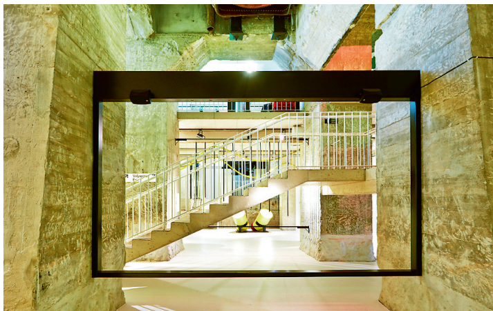
Betoonist trepid on rajatud massiivsete generaatoreid kandnud postide vahele.
