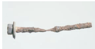
Varjatud korrosioon ja läbiroostetamine.
