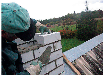
► Kogenud meister saab uue korstnaotsa ladumisel päevaga hakkama.
