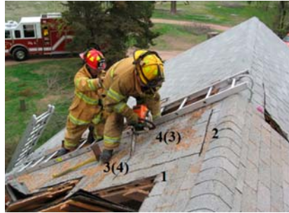
Joonis 66. Ava lõikamise soovitatav järjestus (Autori joonis)
