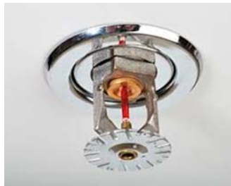
Joonis 58. Sprinkler (Eurovent Est 2014)
