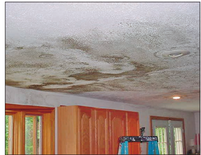
Laepealsete torude pikaajaline leke on lae muutnud varisemisohhtlikuks.
