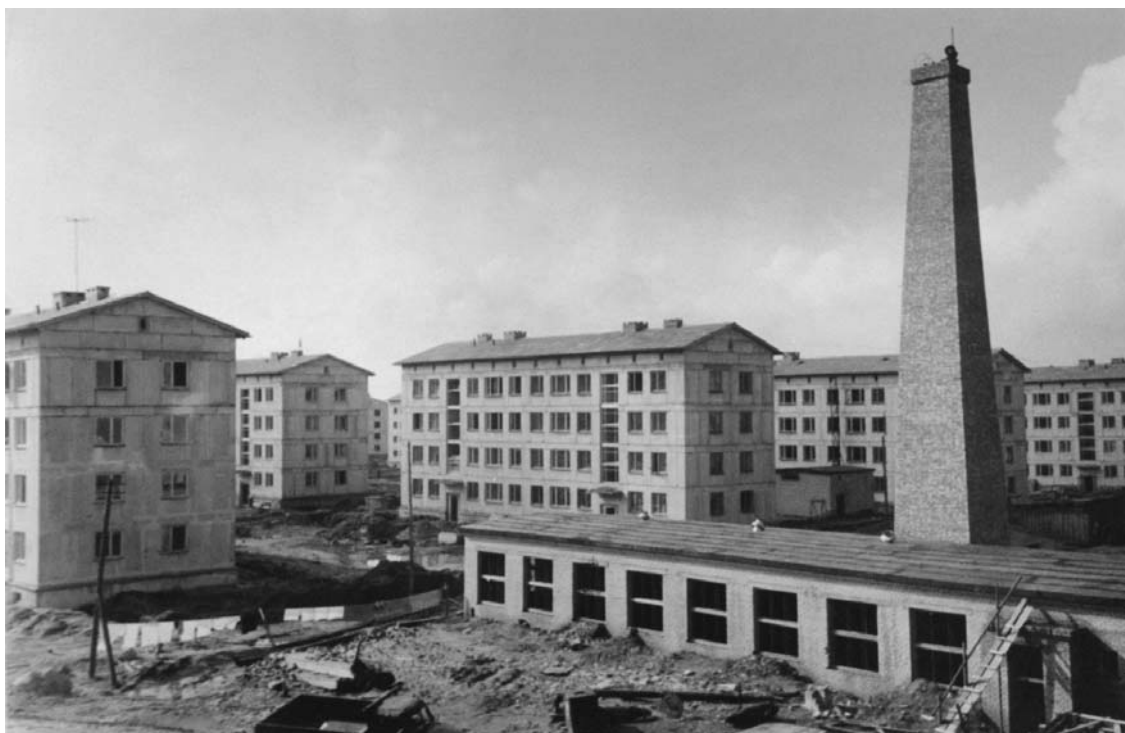
Строительство панельных домов в Таллинне в 1960-е гг.
