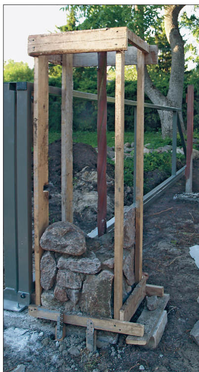
Puidust raam on kinnitatud ja esimesed kivid seguga paika pandud.
