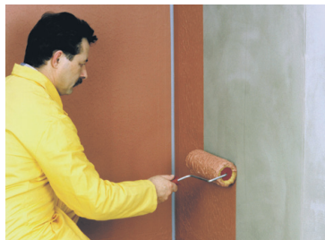
Hüdroisolatsioonimassi weber.tec 822 seinale kandmine maalirulliga
