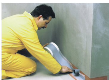
Hüdroisolatsioonilindi weber.tec 828 paigaldamine
