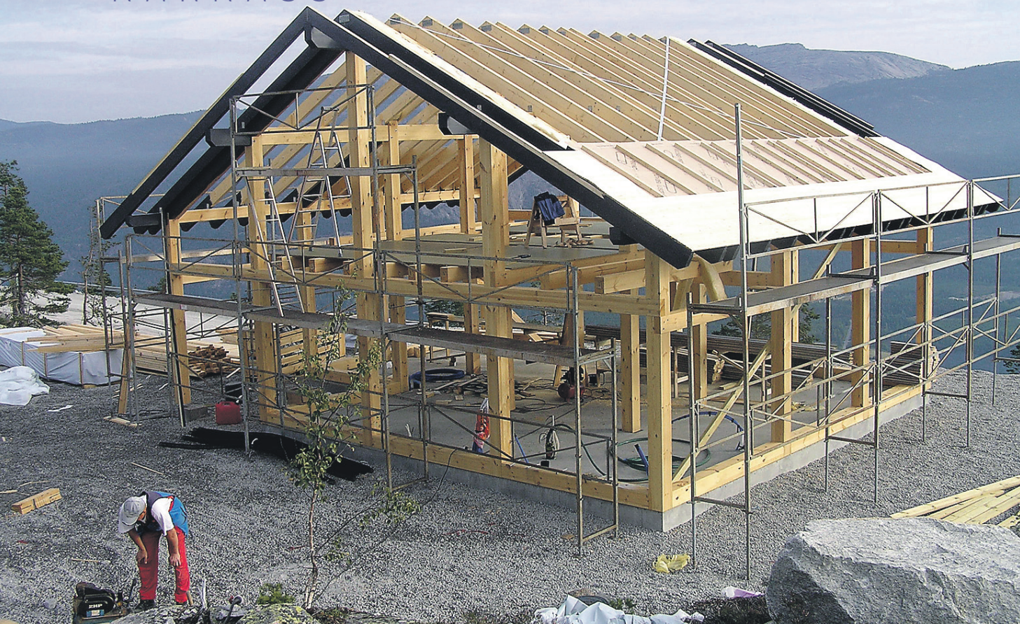
MOUNTAIN Loghome OÜ püstitab Norras post&beam -tüüpi puitkarkassmaja, millel on liimpuidust talastik. FOTOD: TOOTJA
