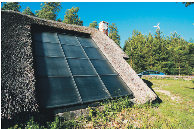
EESTI taluhoone, kus on näha, et päikesepaneelid või -kollektorid saab paigutada ka katusesse.
