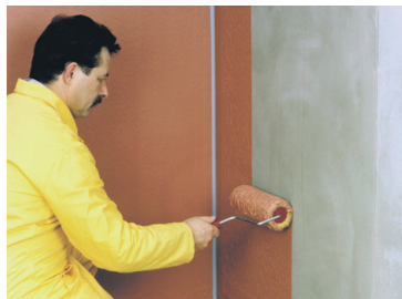
Hüdroisolatsioonimassi weber.tec 822 seinale kandmine maalrirulliga
