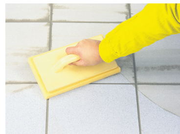
Plaadipindade puhastamine vuugisegust
