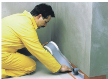
Hüdroisolatsioonilindi weber.tec 828 paigaldamine
