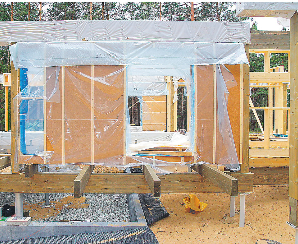
VÄLISSEINA element, mis tehases valmis tehti.
