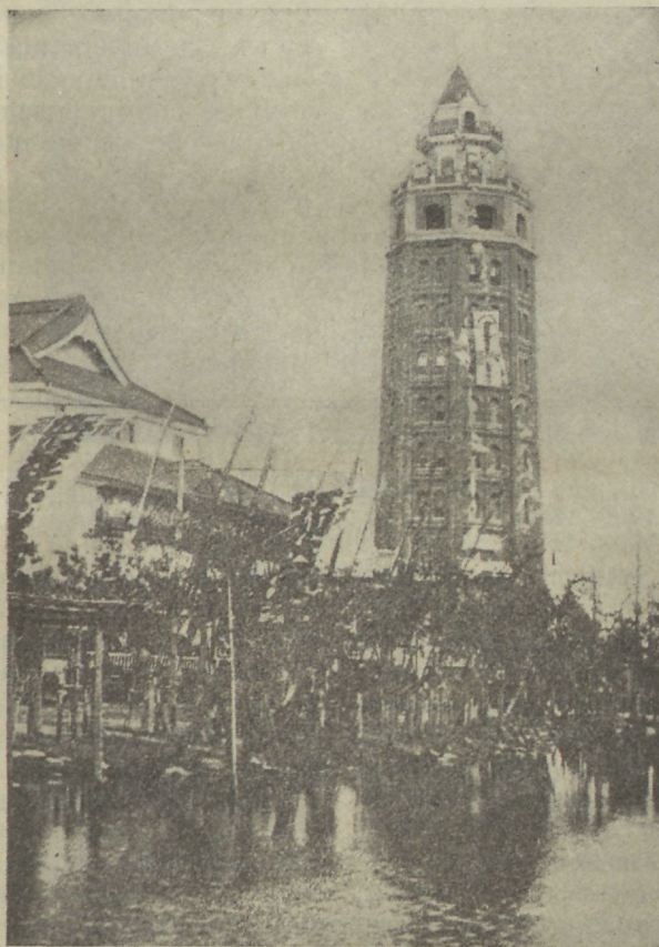
Torn Asakusa pargis Tokios, mille ümberkukkumisel 700 inimest surma said.
