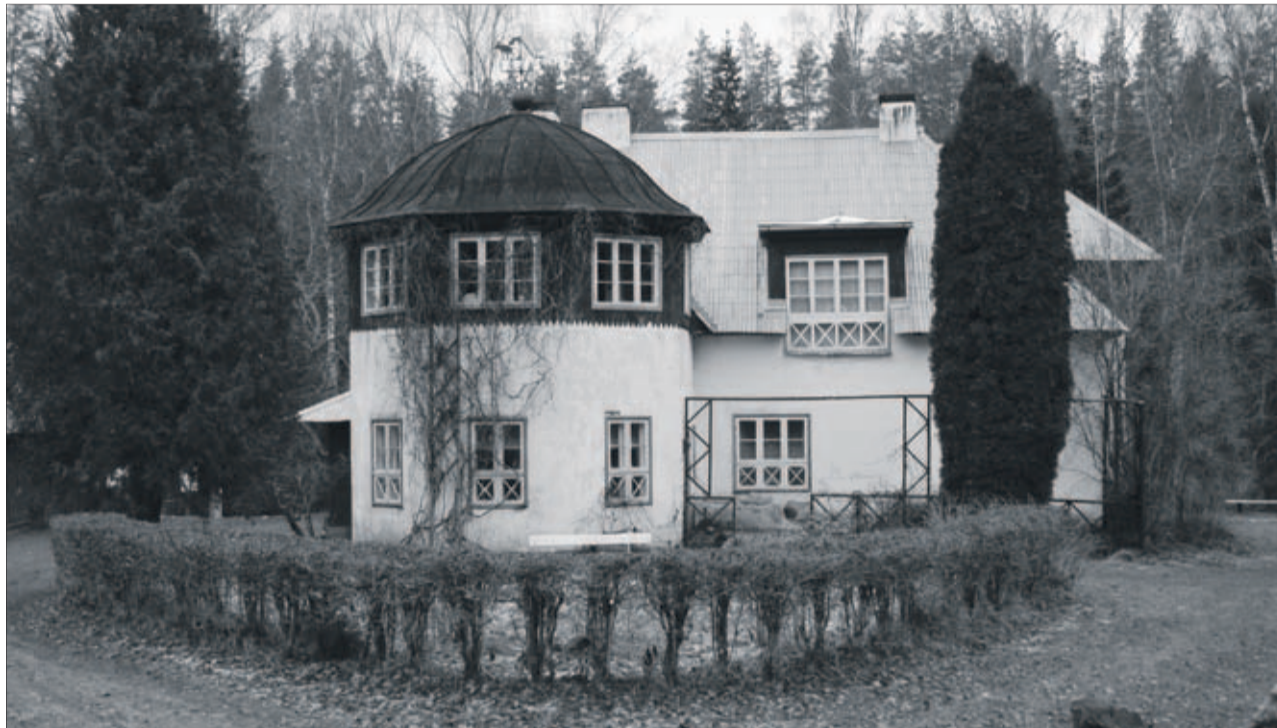
Väikese talukoha (12 ha) Valgejõe kaldal ostis 1914 Jakob Hurda väimees, pastor Aleksander Mohrfeldt. Talus oli eeskujulik viljapuu- ja köetav kasvuhoone, jõel väike elektrijaam. 1925–1928 ehitas Mohrfeldt koos väimehe, Estonia ooperilaulja Karl Viitoliga uue esindusliku valgeks krohvitud kuuekandilise nurgatorniga betoonkivist maja Hanno Kompuse projekti järgi. FOTO HEIKI PÄRDI
