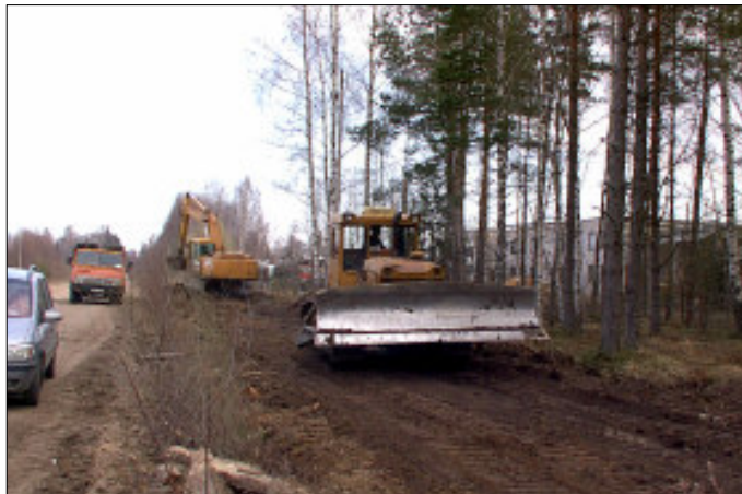
Tänavaäärsete kraavide korrastamine ja veetrasside ehitus on konkreetne näide ühe osa valla infra- ja kommunikatsioonide arengukava täitmisest.
