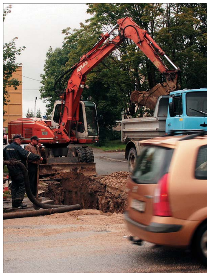
Vektorustiku paigaldamine Kruusa tänaval.
