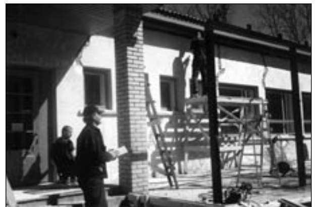
Remondimehed tööhoos, et jaanipäevaks kena ilmaga maja külale üle anda – millega nad said ka väga hästi hakkama – aitäh!
