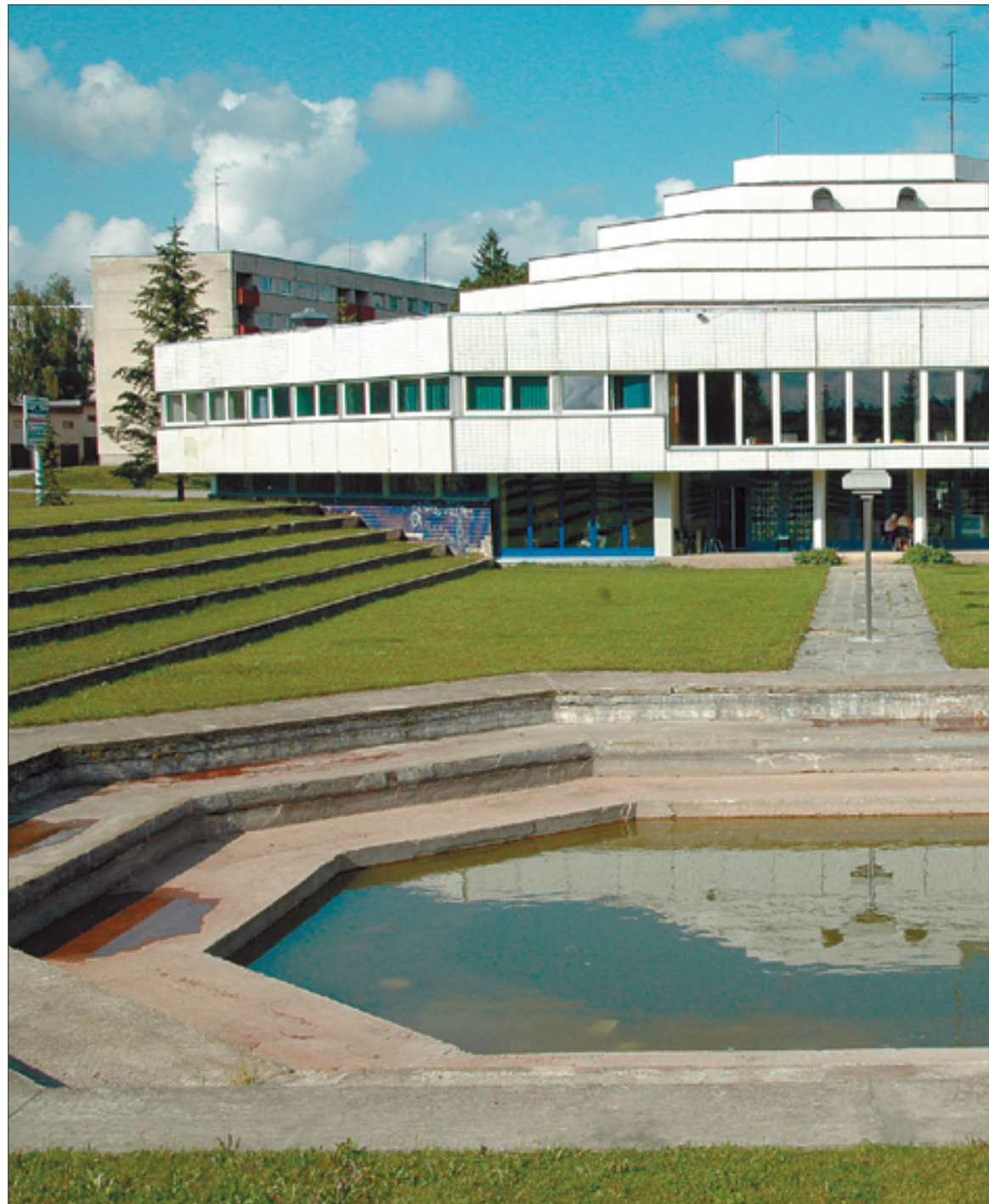
Okta Centrum, endine Rapla KEKi haldushoone, on üks arhitekt Toomas Reinu huvitavamaid töid.
